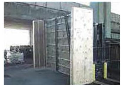
En 2003, lors des travaux de réfection du tunnel Notre-Dame-de-Grâce de l'autoroute Décarie, des rideaux acoustiques ont été utilisés afin de fermer la zone des travaux. Une structure métallique a été installée aux extrémités du tunnel Notre-Dame-de-Grâce afin de mettre en place ce type de mesure (figures 9 et 10).
