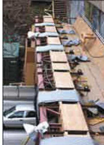
Pendant le jour, les rideaux étaient relevés afin de permettre la circulation des véhicules. Ces rideaux étaient attachés à une structure métallique. Le sommet ainsi que les côtés de la structure ont été fermés à l'aide de contreplaqué afin de s'assurer de l'étanchéité de l'ensemble lorsque les rideaux étaient abaissés.
