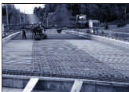
Figure 6 : Bétonnage de la dalle du tablier du pont
