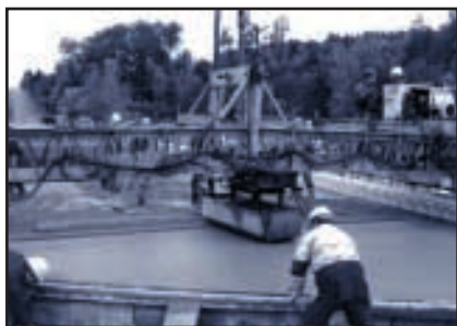
Figure 6 : Bétonnage de la dalle du tablier du pont
