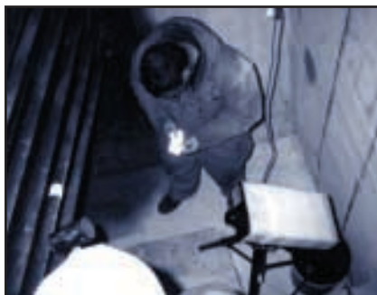
Figure 9 : Mesure typique d'un toron de chambre d'ancrage par interférométrie laser
