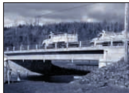
Figure 7 : Essais de chargement sur le pont à l'aide de camions
