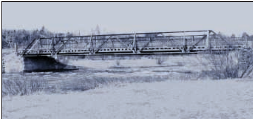
Figure 1 : Ancien pont situé à Wotton
