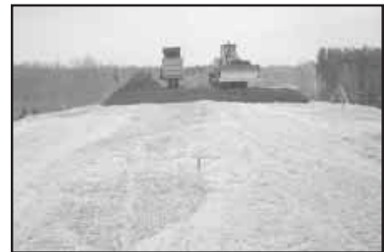
Figure 6 : Mise en place de la fibre de bois puis de la surcharge
