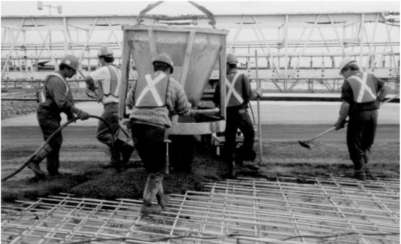
Figure 1. Mise en place du BHPFA pour le pont du boulevard Cavendish
