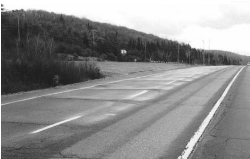
Figure 2 : Soulèvement en surface, courtes longueurs d'onde
