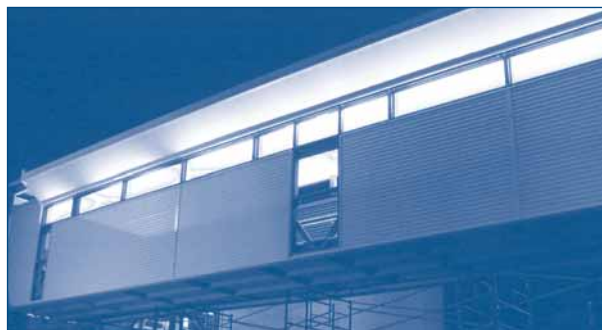
Nouvelle rampe piétonnière fenestrée qui offre un éclairage naturel le jour et un bel effet en soirée.
