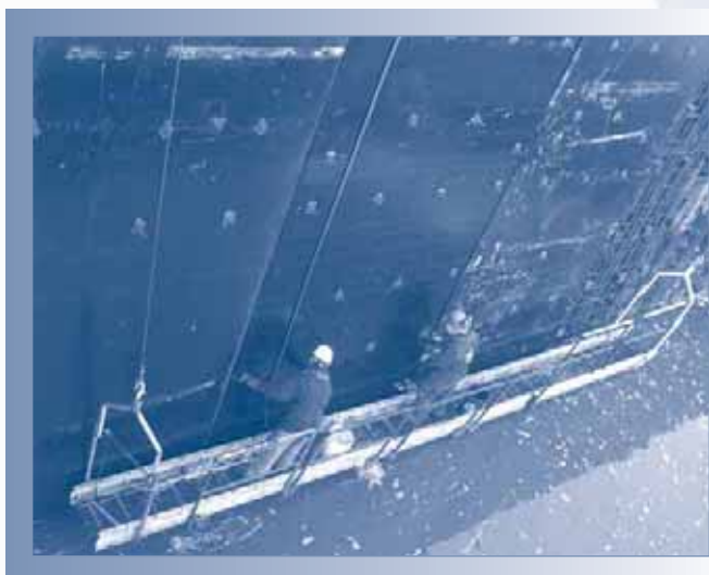
Réparation de la palplanche.
