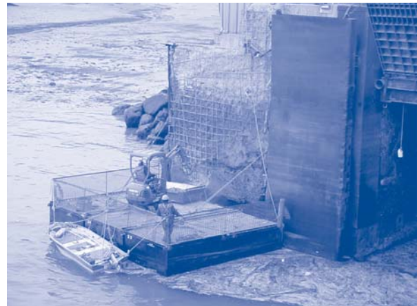
Travaux de réfection de la face d'accostage au quai de Saint-Joseph-de-la-Rive
