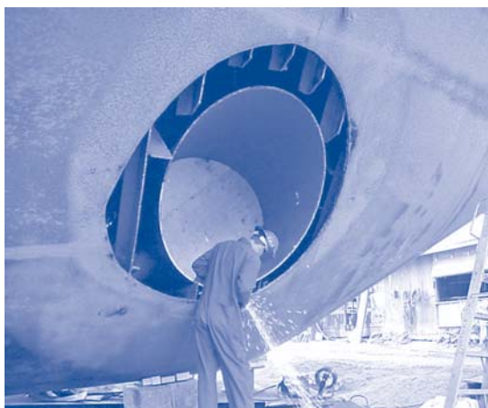
Installation d'un propulseur d'étrave sur le N.M. Lomer-Gouin pour faciliter les manœuvres d'accostage du navire
