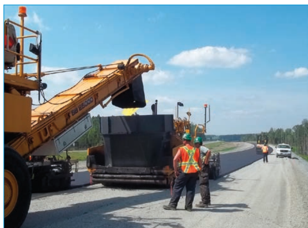
■ Travaux d'asphaltage sur l'autoroute 73 à la hauteur de Saint-Joseph-de-Beauce.
