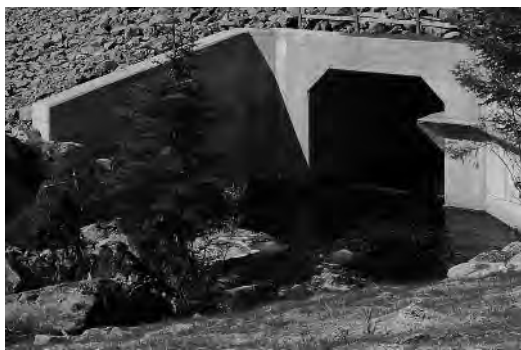
Portique en béton armé sur la nouvelle route entre Québec et Saguenay.
