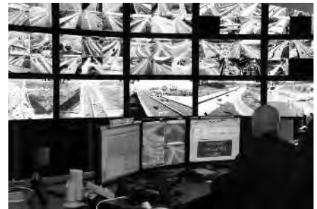
Afin d'accroître la sécurité, le personnel du Centre intégré de gestion de la circulation de Québec veille à détecter tout événement sur le réseau routier, notamment au moyen des caméras de circulation, et diffuse de l'information aux usagers sur les panneaux à messages variables.
