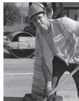
M. Carl Létourneau, ouvrier au Centre de services de Québec, se trouve ici à pied d'œuvre sur le chantier de reconstruction d'un ponton traversant le chemin Royal (route 368) à Saint-Jean-de-l'Île-d'Orléans.
