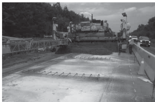
Technique de reconstruction par recouvrement de béton d'une chaussée souple sur l'autoroute 40 à L'Assomption.
