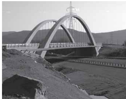
Pont de l'autoroute 73 enjambant la route 175 à Stoneham, construit en 2011.
