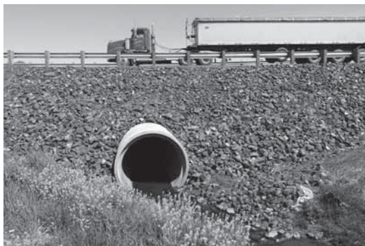
Le ministère des Transports gère un parc de plus de 58 000 ponceaux sur son réseau routier, ce qui représente 2 ponceaux par kilomètre.
