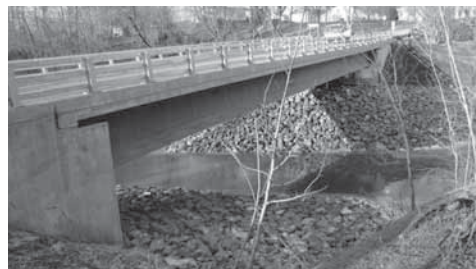
Pont du Docteur J.-W. Paquin dans le rang Sainte-Cécile au-dessus de la rivière David, à Saint-David, construit en 2011.
