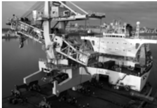
Le chargeur de navires du terminal de Beauport fait partie intégrante d'un système de manutention qui, en plus d'augmenter la productivité lors des chargements et des déchargements de marchandise en vrac, contribue à la réduction d'émissions de GES.
