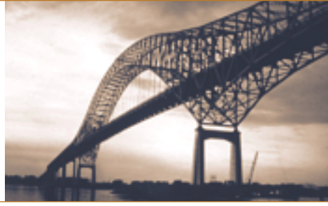
Pont Laviolette, à Trois-Rivières : pont de type arche en treillis métallique avec tablier suspendu.
