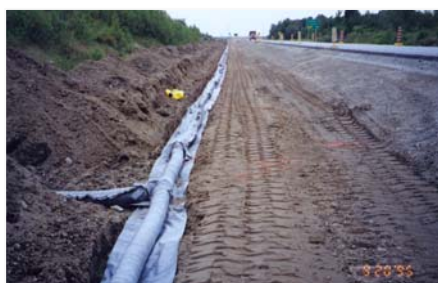
Figure 1 : Drain de rive enveloppé de géotextile filtrant (type IV)
