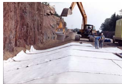
Figure 3 : Géocomposite bentonitique pour imperméabiliser un fossé
