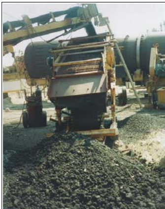
Photo 1 : Fabrication du GBR
