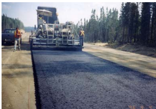
Photo 3 : Pose de l'enrobé recyclé MB-20
