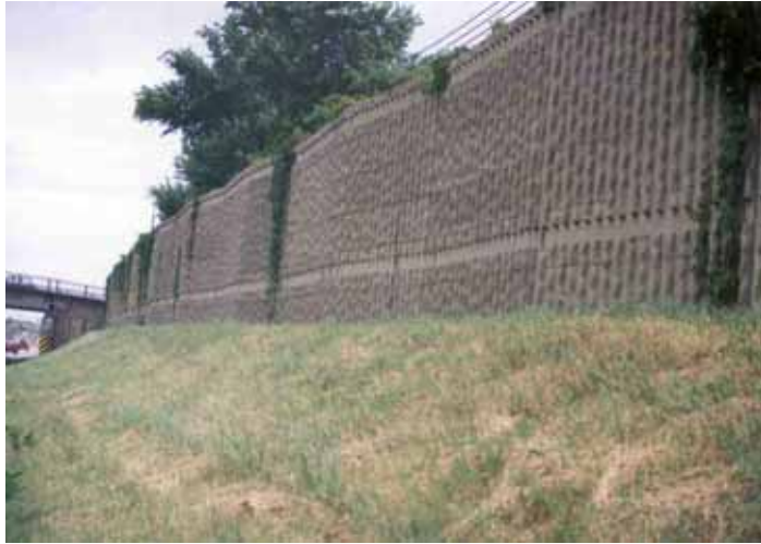
Écran réalisé avec des fibres de bois
