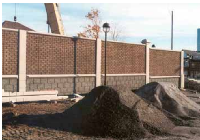
Écran réalisé avec un schiste expansé
