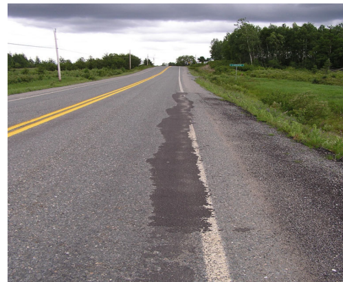
Figure 2 : Rapiéçage en rive de chaussée
