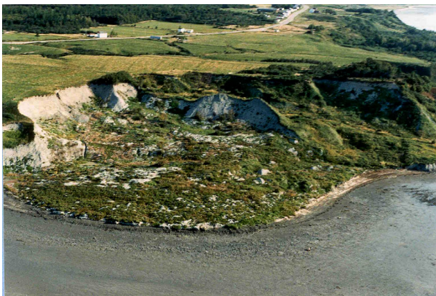
Figure 1 : Exemple de coulée argileuse (route 138)
