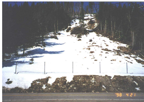
Figure 2 : Clôture de captage de blocs (route 169)
