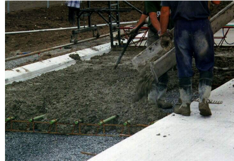
Figure 3 : réparation en profondeur en béton
