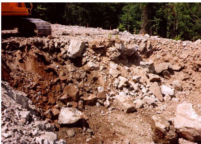
Figure 1 : excavation dans un remblai existant sur la Côte-Nord
