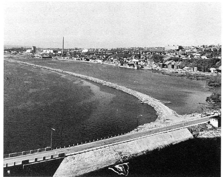
Abords du pont de l'Île d'Orléans, jetée du boulevard des Grèves.
