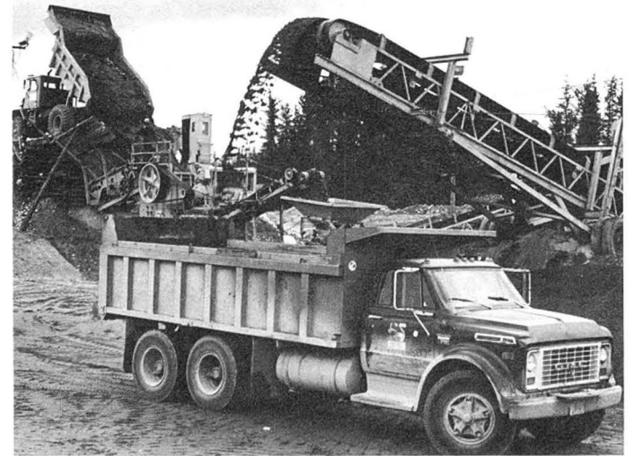
Usine de fabrication de béton bitumineux.
