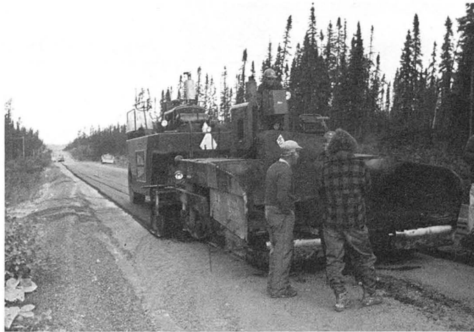
Pavage de la route 113, Chibougamau.
