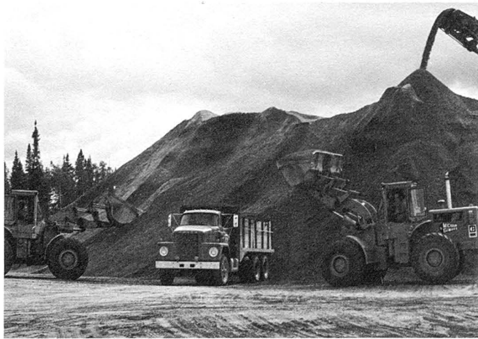
Les camions lourds font partie du décor dans la construction routière.
