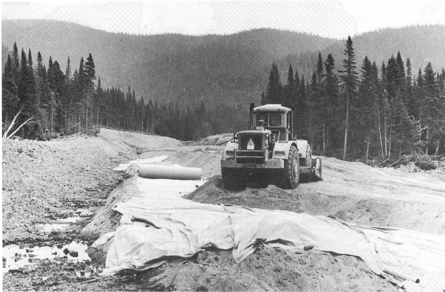
Hâvre St-Nicolas Route 138 (15) 31 juillet 1973. Vue Est des approches au chaînage 145+00. Pose du Bidim et remblayage.
