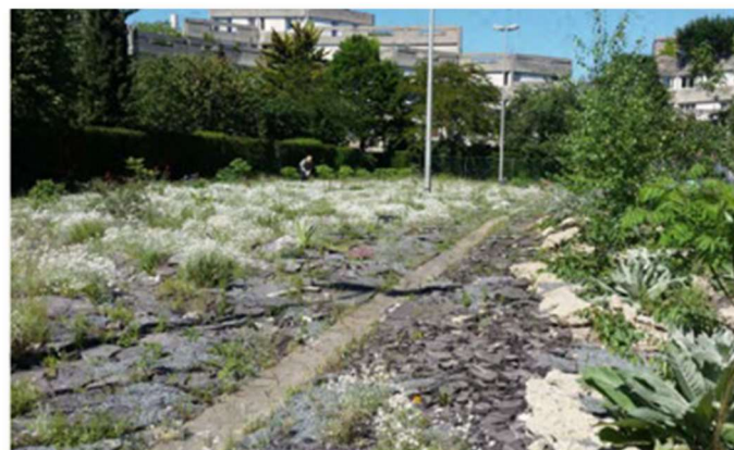
Concassage de l'enrobé laissé sur place et végétalisation spontanée, jardin des Joyeux à Aubervilliers (Source : « Désimpermeabiliser les villes – Guide opérationnel pour (re)découvrir les sols urbains », Plante & Cité, 2024)
