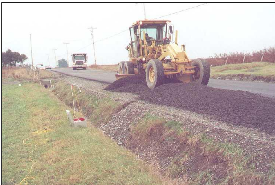
Figure G8 Niveleuse utilisée pour l'épandage des résidus sur l'accotement du tronçon désigné. Dans l'avant-plan, noter le poste d'échantillonnage de l'air ambiant.
