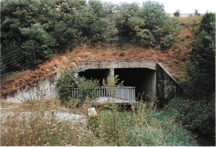
DOUBLE CADRE : difficulté à traiter les extrémités du passage.
