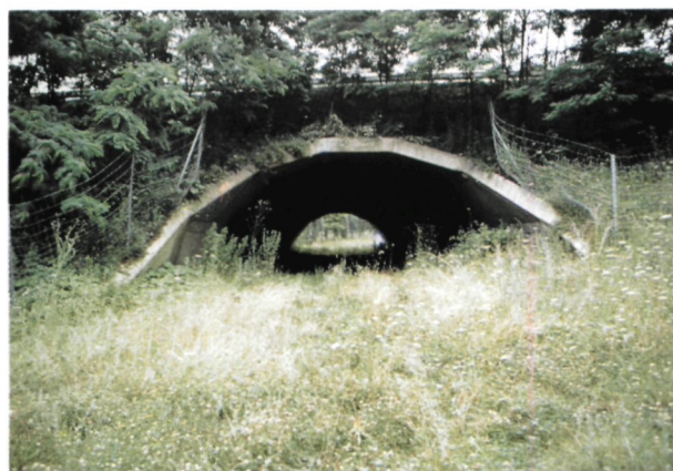
A31 Thionville-Luxembourg : L = 54 \text{ m} , l = 9 \text{ m} , h = 3 \text{ m } 70 . Le passage est régulièrement emprunté par le chevreuil, occasionnellement par le cerf et le sanglier. Photo C.E.T.E. de l'Est
