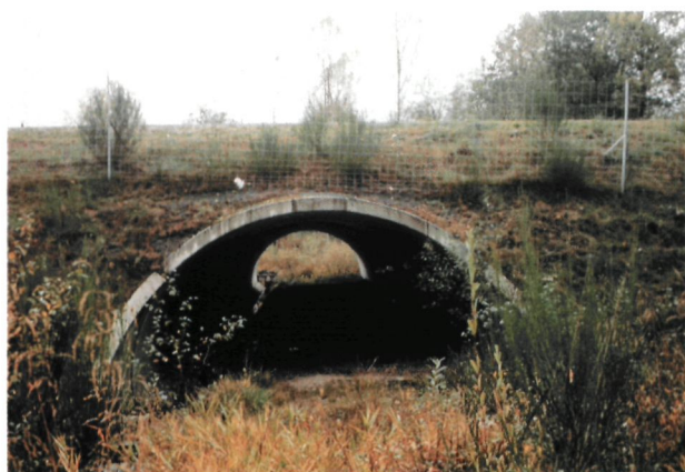
RN 4 déviation de Lunéville : malgré ses faibles dimensions ( l = 6 \text{ m} , h = 3 \text{ m } 50 ) le passage est régulièrement emprunté par le chevreuil. Photo C.E.T.E. de l'Est
