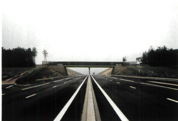
AUTOROUTE A26 (Châlons-Troyes). Pont dalle avec un seul appui central et culée en mur "loffel". Photo C.E.T.E. de l'Est
