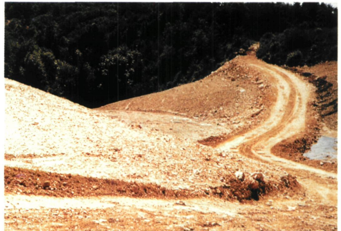
L'AMENAGEMENT DE VASTES DEPÔTS DE MATERIAUX aux abords des passages perturbe les déplacements de la faune. En l'absence de plantation les dépôts cicatrisent mal. En revanche, convenablement modelés puis plantés, ils peuvent dans certaines circonstances être acceptables, voire améliorer l'attractivité du passage. (Photo : C.E.T.E. de Lyon).
