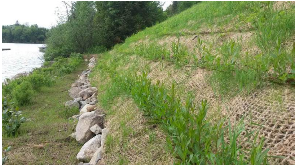
Fig. 11 – Enrochement des berges et stabilisation végétale. © AUBIER environnement
