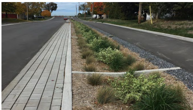
Figure 10 : Biorétention sur la rue Sainte-Claire à Rivière-du-Loup
