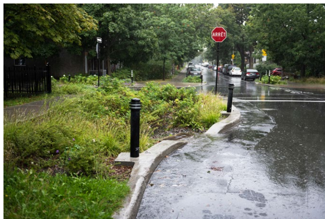
Figure 5 : Avancée de trottoir drainante à Montréal (intersection rue de l'Ukraine et 12 e Avenue)
