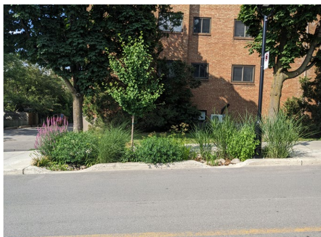
Figure 7 : Fosse d'arbres drainante avec bordure abaissée (permettant de capter les eaux de ruissellement) à Montréal (rue Versailles)
