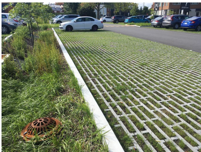
Figure 2 : Réfection du stationnement Pierre-Laporte à Victoriaville avec biorétention et pavé perméable
