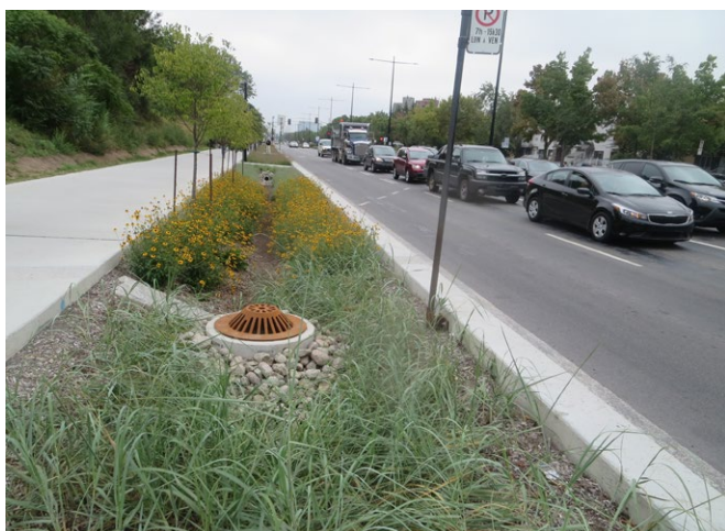
Figure 6 : Système de biorétention sur l'avenue Papineau à Montréal
