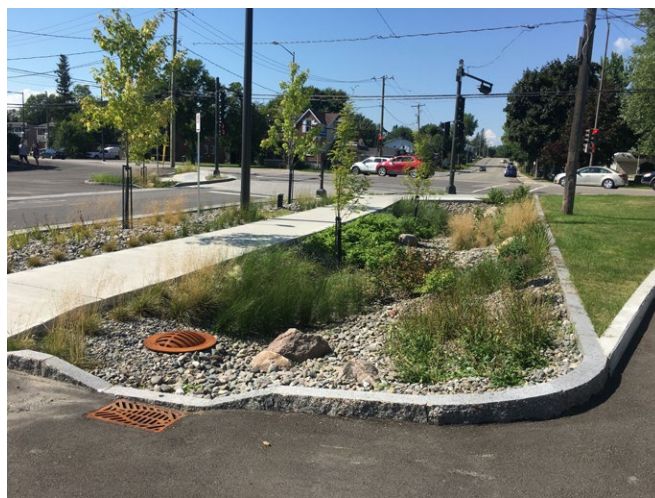
Figure 3 : Système de biorétention sur le boulevard Neuville (entrée du parc des Saules) à Québec
