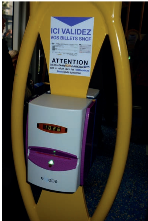
Gare périurbaine équipée de distributeurs automatiques de billets Source Cerema Centre-Est
