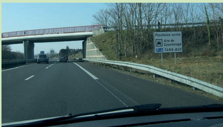
Signalisation des parcs de covoiturage sur l'A68, pour accéder à la ligne à haut niveau de service Tarn Express entre Albi et Saint-Sulpice
