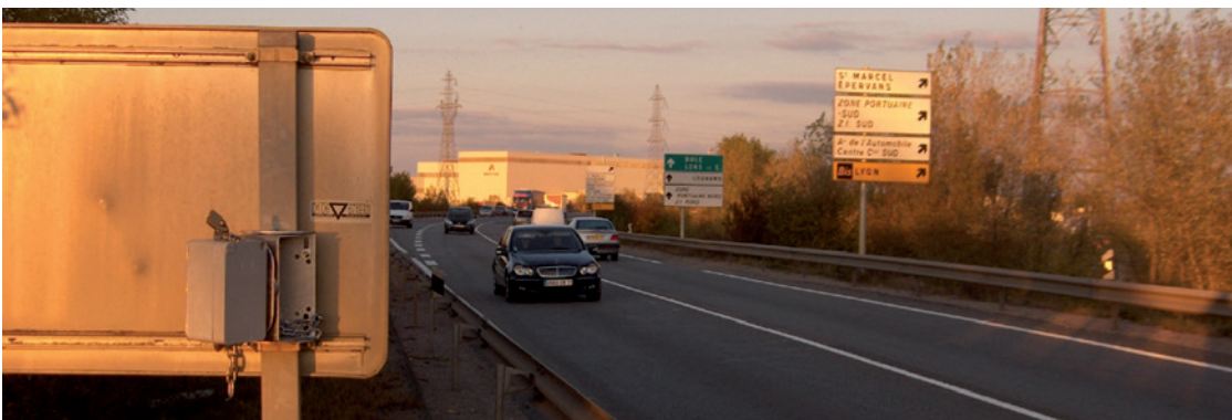
Compteurs automatiques de type radar (source : Cerema)
