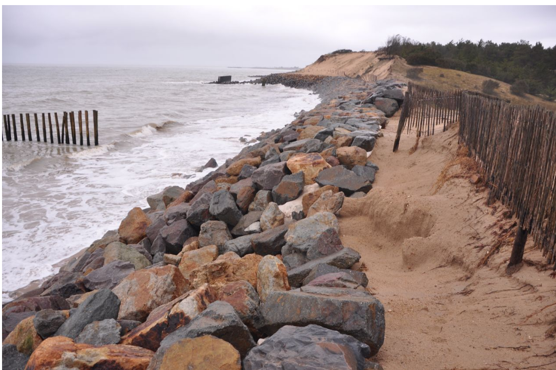
Illustration 65 : perré de la pointe de la Fosse à Barbâtre (1) et perré des Eloux à L'Épine, construit en conditions d'urgence (2) (source : CCIN)
