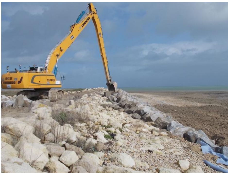
Illustration 55 : renforcement des digues de Loix (source : CD17 – auteur : J. Garnier)
