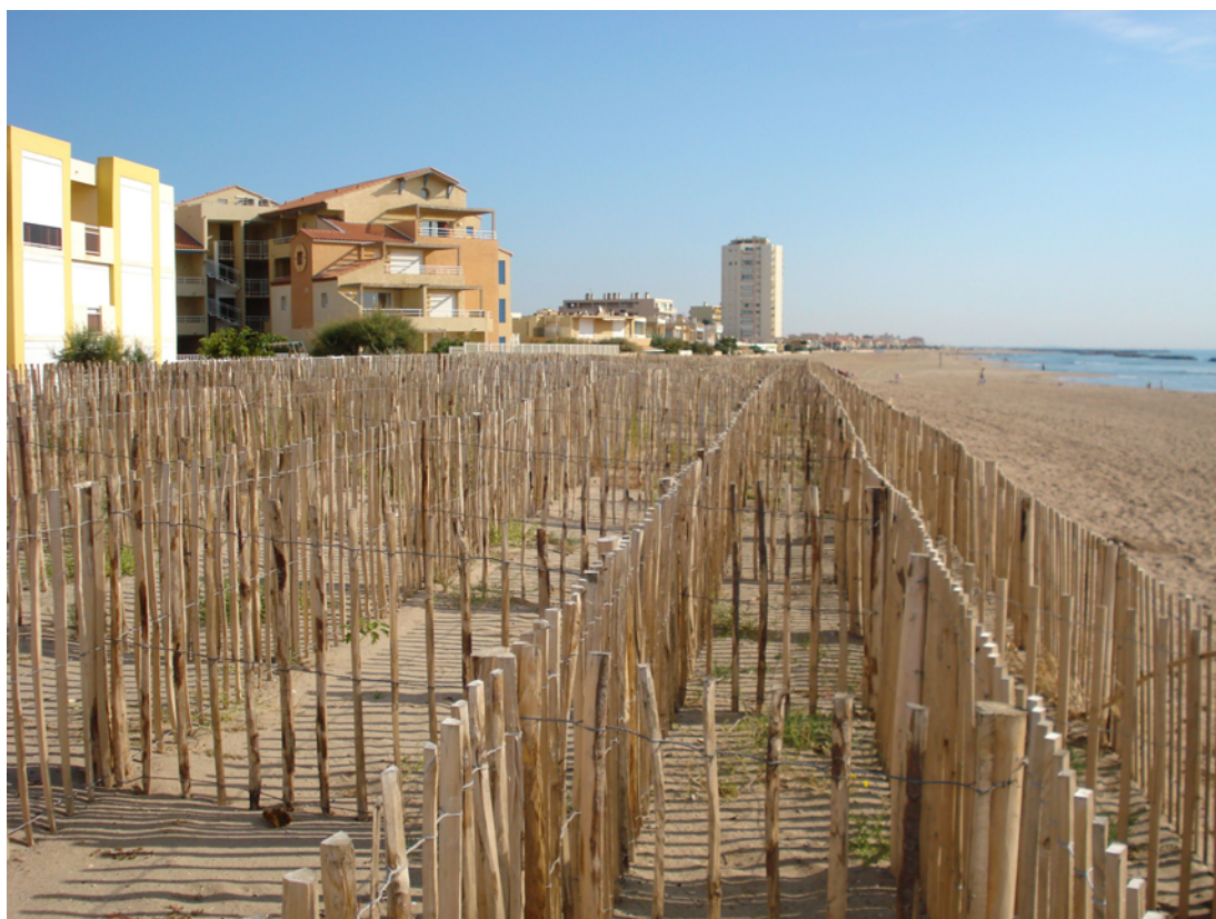
Illustration 7 : création d'un cordon dunaire à Valras (auteur : Cerema)
