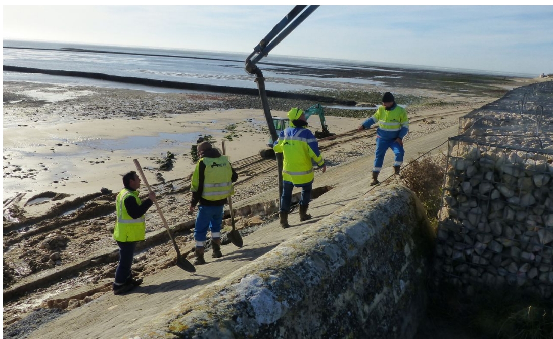
Illustration 61 : Réparation de la digue de la Loge-du-Guet – vue globale et vue détaillée (source : www.notre-ile-de-re.com )
