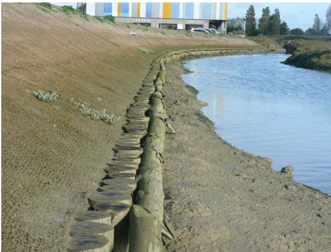
Illustration 59 : quai Gorin à Saint-Gilles-Croix-de-Vie (85) - Tunage et protection végétale (source : DDTM85)
