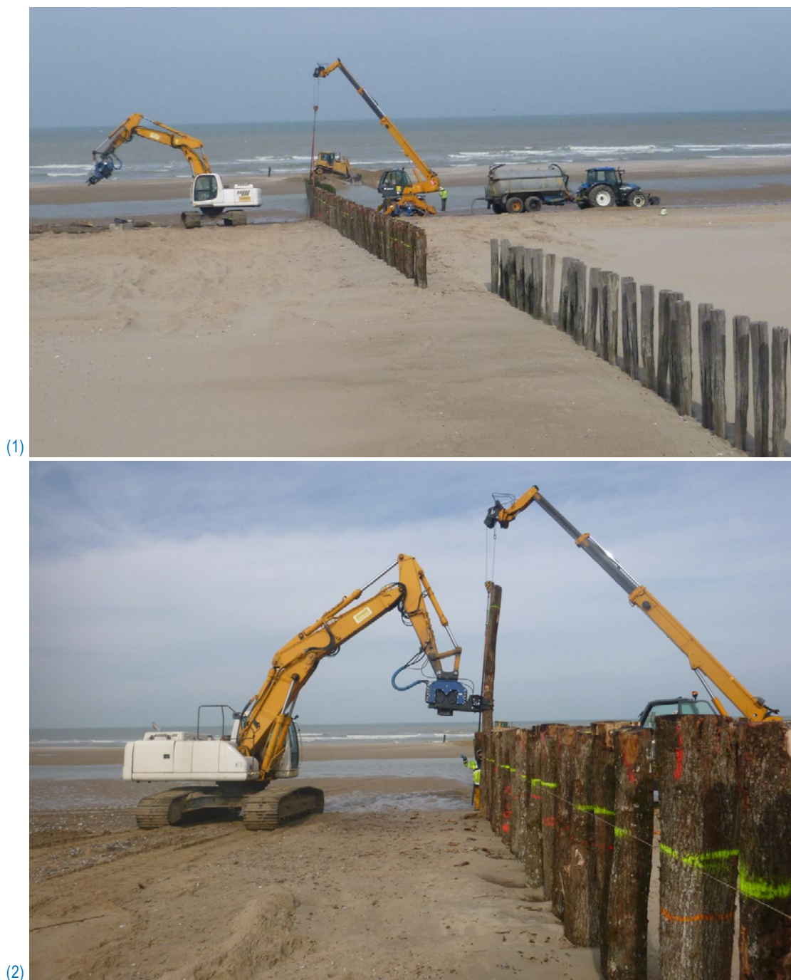
Illustration 72 : épis en cours de remplacement, vue générale du chantier (1) et mise en fiche d'un pieu (2) (source : DDTM62)
