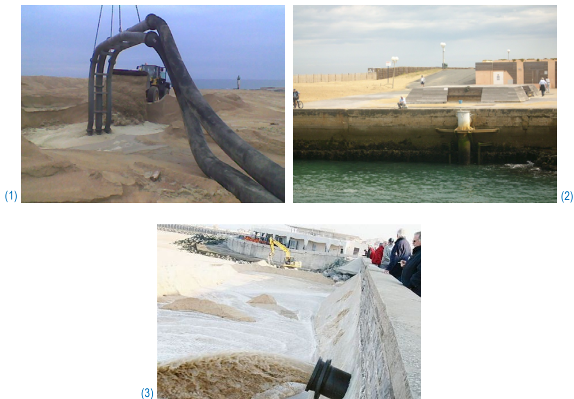
Illustration 25 : prélèvement de sable au nord (1), passage de la conduite sous le chenal (2), rejet et étalage au sud (3) (auteurs : Ville de Capbreton et Virginie Chaouch)
