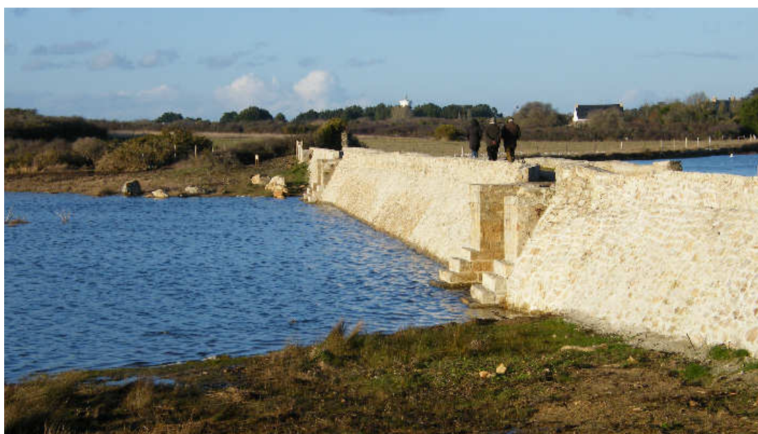
Illustration 60 : digue de Brénéguy – vue globale (source : locmariaquer.info)
