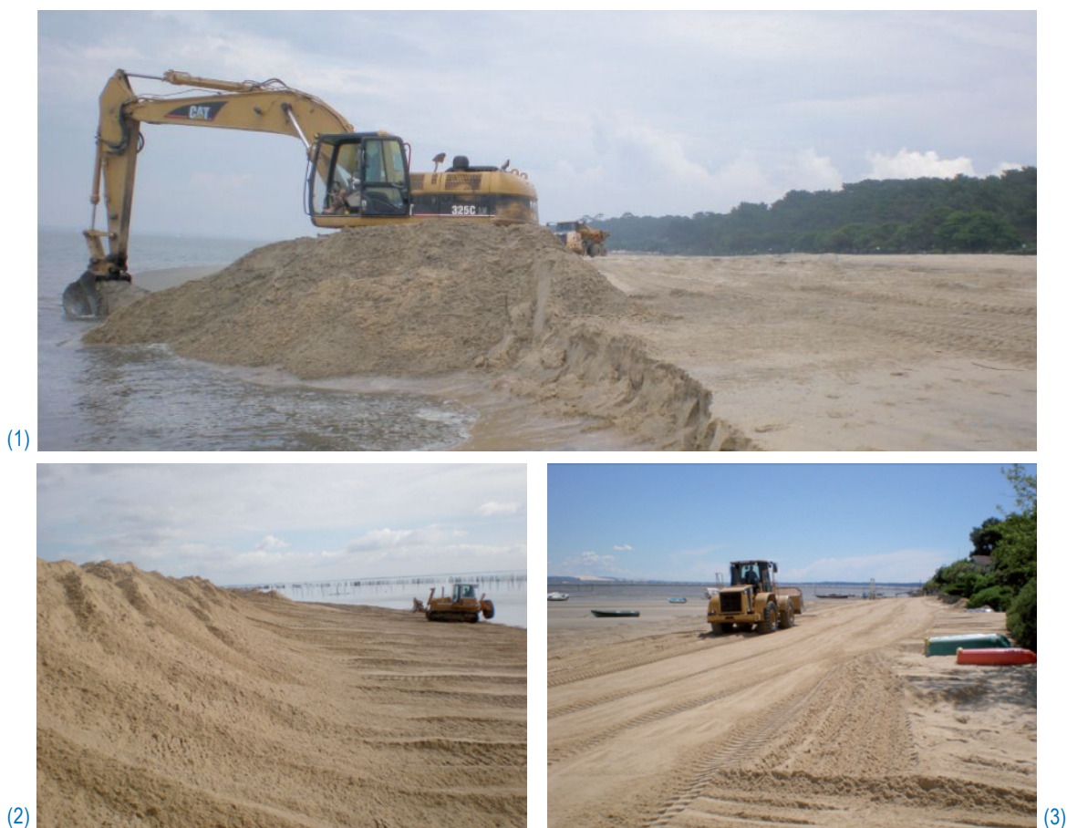
Illustration 31 : prélèvement (1), déplacement (2) et régalinge (3) (source : Syndicat intercommunal du bassin d'Arcachon)
