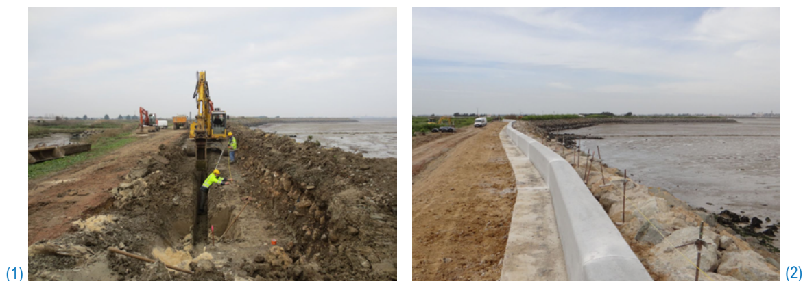
Illustration 58 : renforcement de la digue du Bouclard sur l'île de Noirmoutier : ouverture de tranchée (1) et construction du muret (2) (source : CCIN)
