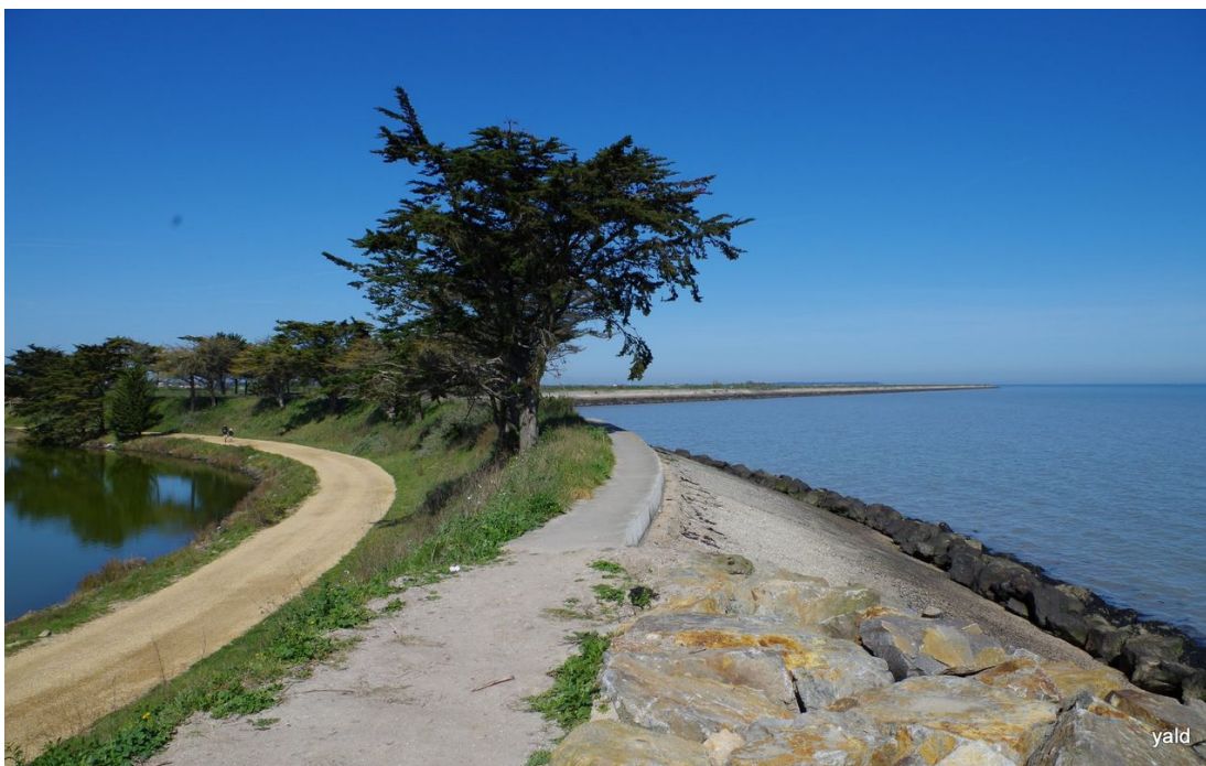
Illustration 9 : digue de Noirmoutiers (auteur : Yann Deniaud, Cerema)
