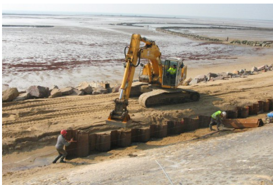
Illustration 66 : coupe-type (1) (auteur : Arcadis) et photographies de l'intervention sur le perré de la Guérinière : mise en œuvre des palplanches (2), réalisation de la longrine (3) (auteur : Michel Pottier)
