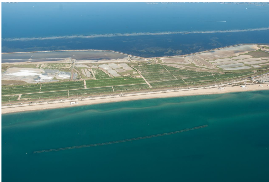
Illustration 74 : géotubes immergés en protection d'une portion du lido de Sète à Marseillan (source : Thau Agglo)
