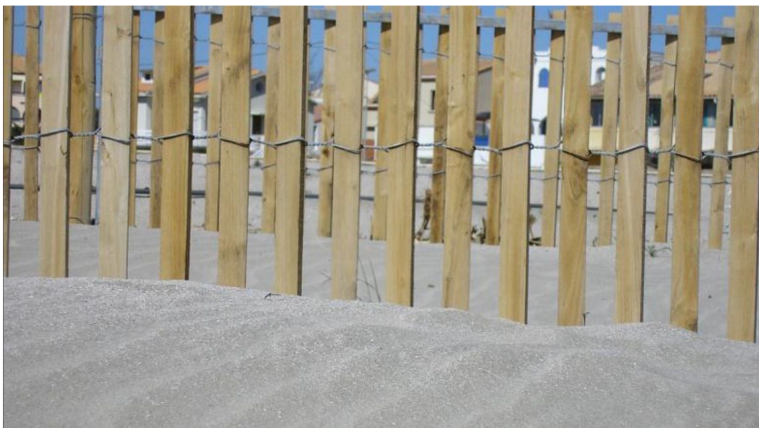
Illustration 46 : ganivelles avec lattes sciées (source : Hugues Heurtefeux, EID)
