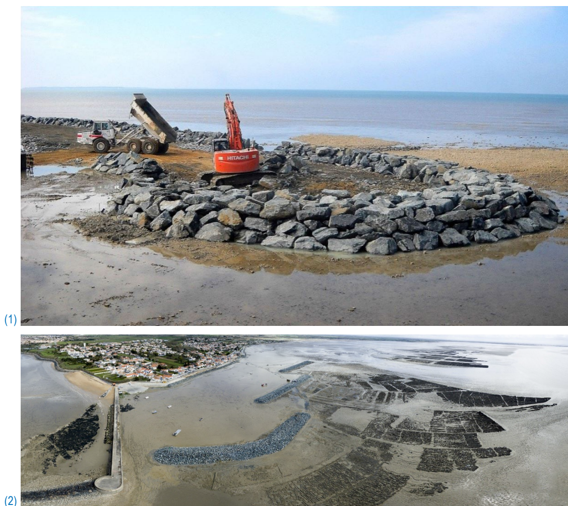
Illustration 73 : brise-lames en protection des Boucholeurs : ouvrages en construction (1) et achevés (2) (source : Silycaf)
