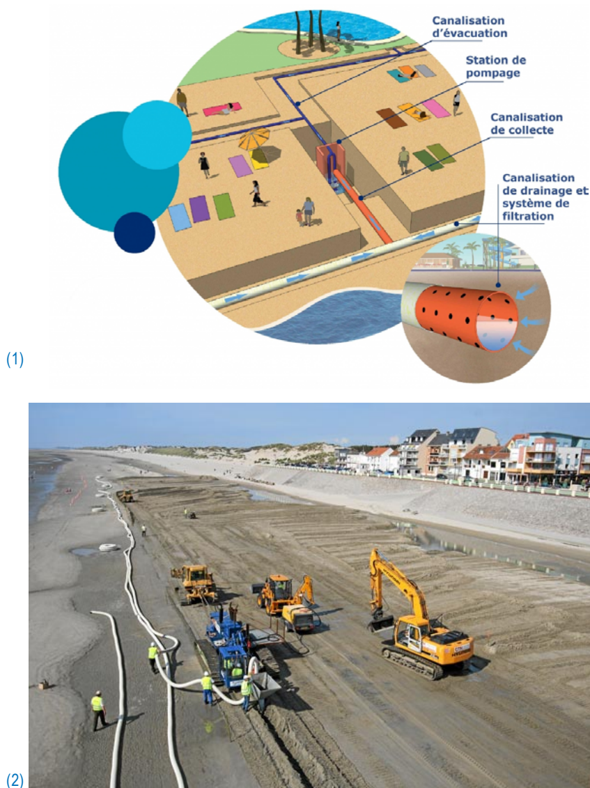
Illustration 36 : principe (source : Écoplage® - http://www.ecoplage.com/ ] (1) et réalisation du dispositif Écoplage® à Quend (80) [Syndicat mixte baie de Somme Grand littoral picard] (2)
