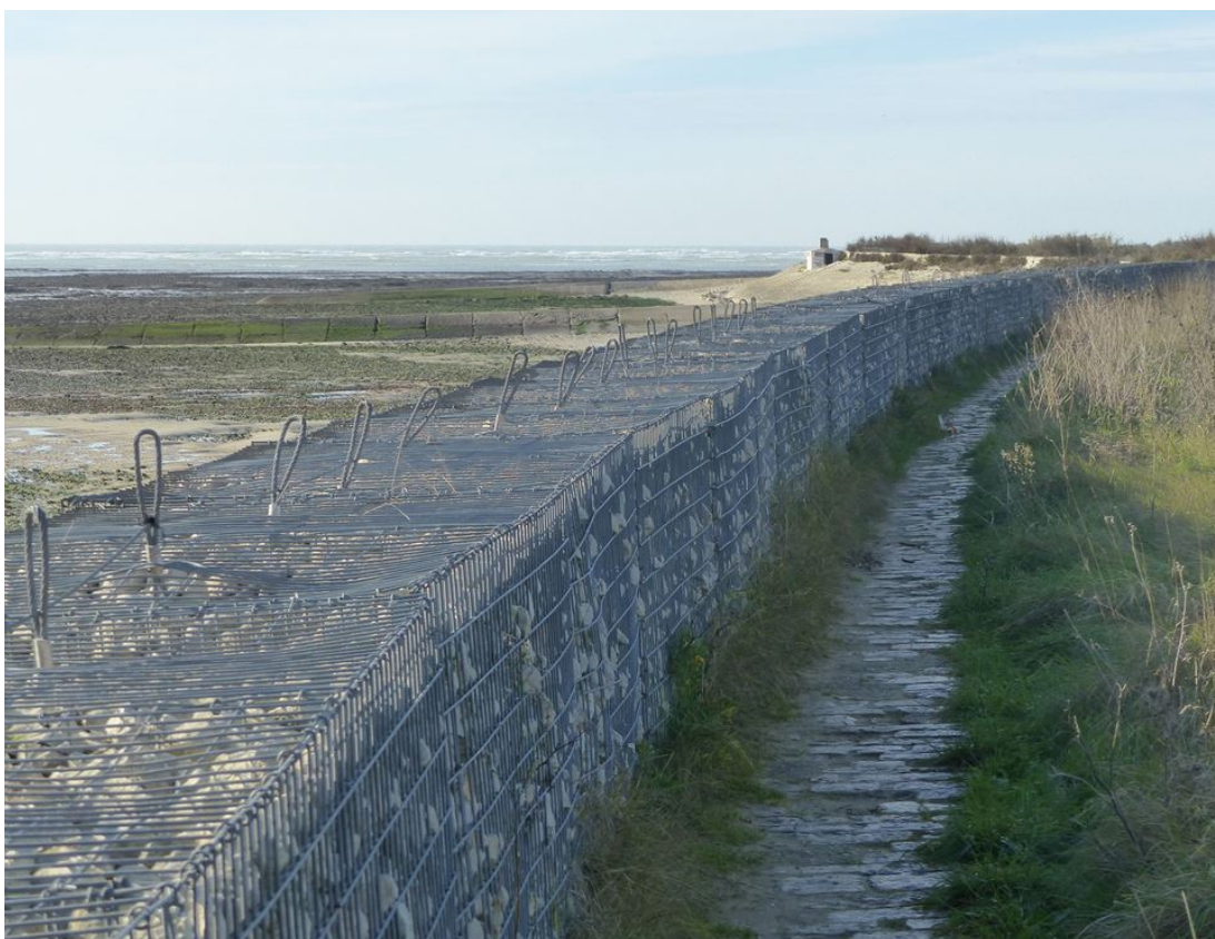
Illustration 70 : gabions surplombant la digue de la Loge du Guet à Ars-en-Ré (17) (source : www.notre-ile-de-re.com )
