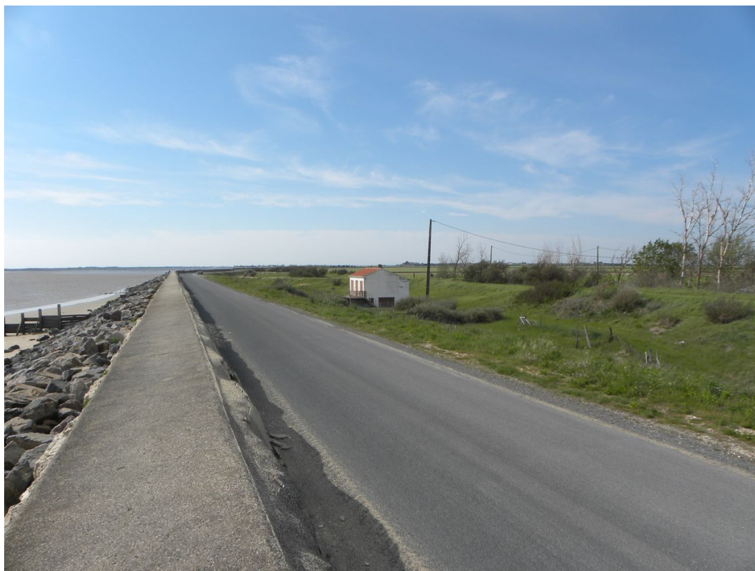
Illustration 48 : une digue de grande hauteur : la digue du Génie à l'Aiguillon-sur-Mer (auteur : Marc Igigabel)
