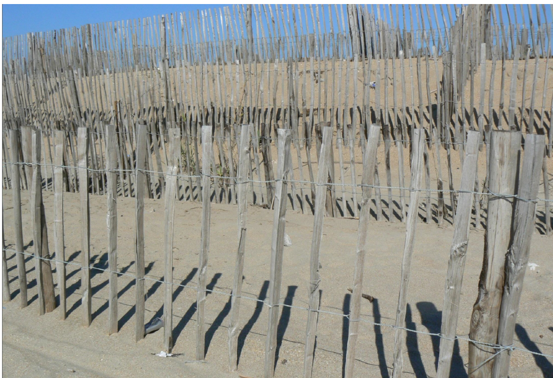
Illustration 45 : ganivelles de perméabilité 60 et 80 % (auteur : Hugues Heurtefeux, EID)
