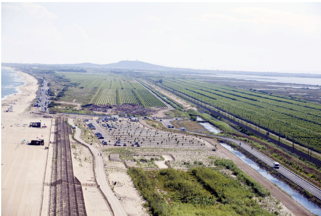
Illustration 19 : vue d'ensemble de l'opération sur le lido de Sète (source : Thau Agglo)
