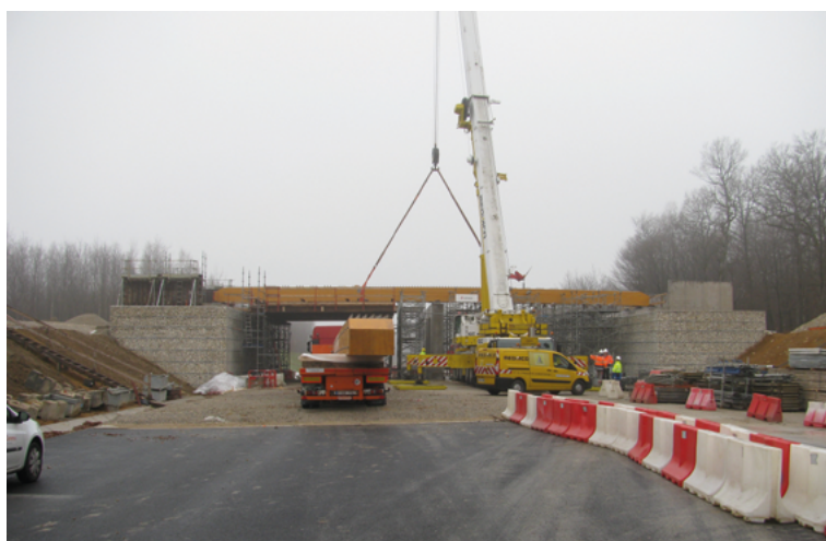
Photo A13 : Mise en œuvre des nervures à la grue (Source : Cerema)
