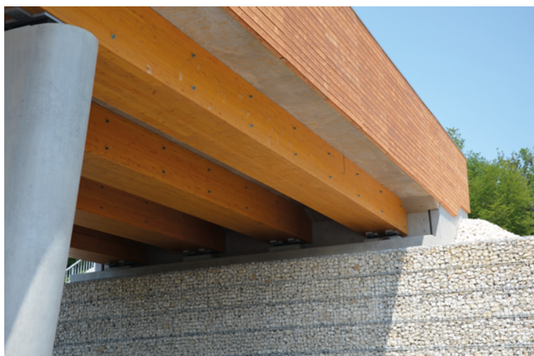
Photo A11 : Intrados du tablier (Source : Cerema)
