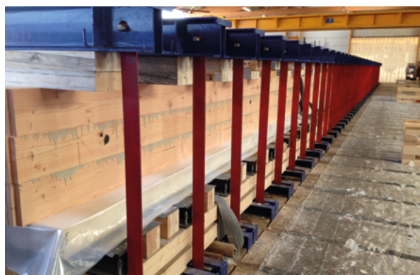
Photo 35 : Bâti de maintien en pression pendant la polymérisation de la colle (Source : Cerema)
