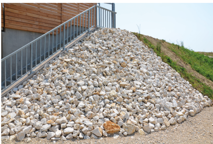
Photo 25 : Exemple d'un quart de cône de remblai contigu de culée recouvert de pierres (Source : DIR Est)
