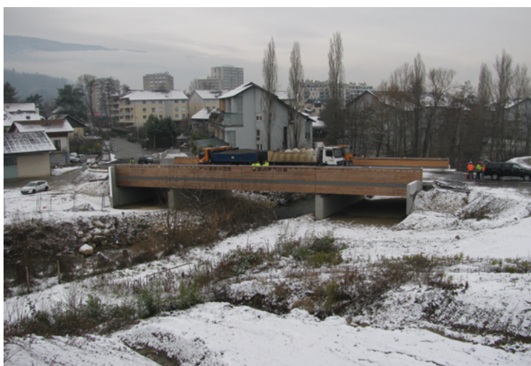
Photo A9 : Épreuves de chargement du pont (Source : Cerema)
