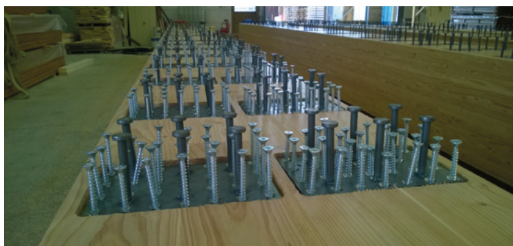
Photo 5 : Connexion bois/béton en cours d'assemblage (Source : Arbonis)
