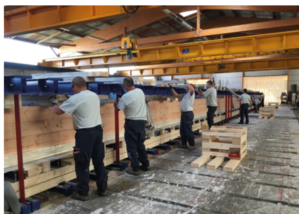
Photo 34 : Mise sous presse d'un bloc de trois poutres unitaires (Source : Cerema)
