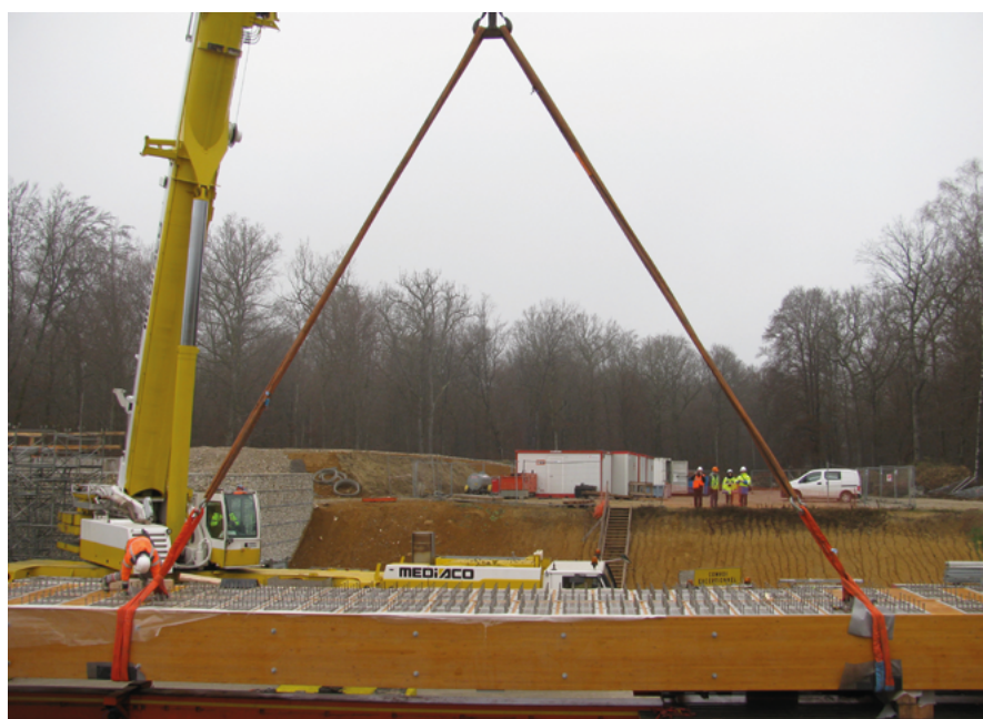
Photo 43 : Prise en charge d'une nervure lamellé-collé par une grue (Source : Cerema)
