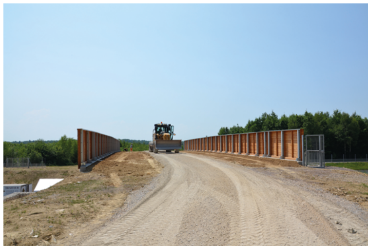
Photo A10 : Vue de l'extrados de l'ouvrage (Source : Cerema)
