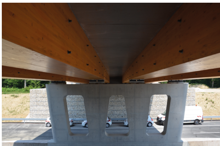
Photo 16 : Exemple de pile voile ajouré avec chevêtre en tête (Source : Cerema)
