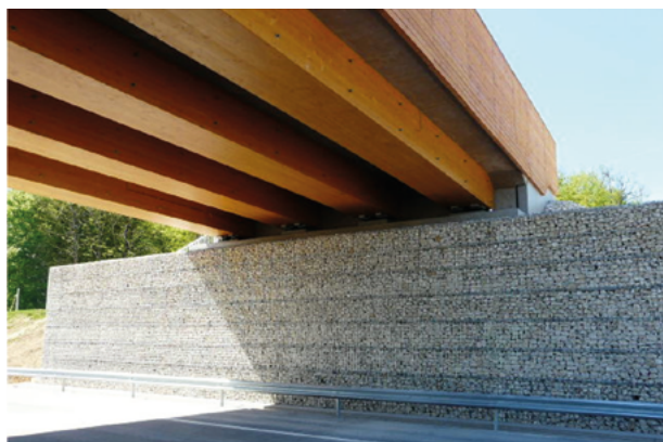
Photos 3 et 4 : Exemple de nervures en bois assemblées par collage de poutres unitaires (À gauche : Source Cerema, à droite : source Nice Côte d'Azur Métropole)
