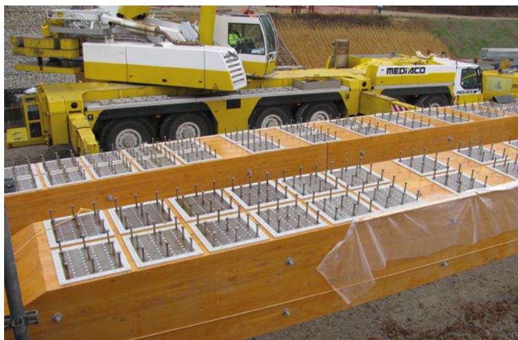
Photo A12 : Livraison des nervures sur site (Source : Cerema)
