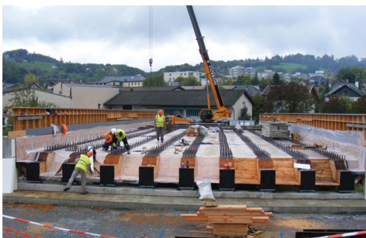
Photo A8 : Mise en œuvre du coffrage perdu (Source : BG Ingénieurs-Conseils)
