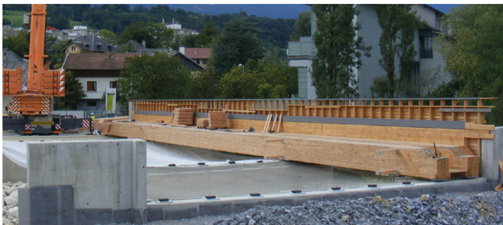
Photo A6 : Pose des nervures sur appuis définitifs (Source : BG Ingénieurs-Conseils)
