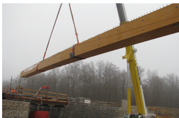
Photo 44 : Mise en place d'une nervure à la grue (Source : Cerema)
