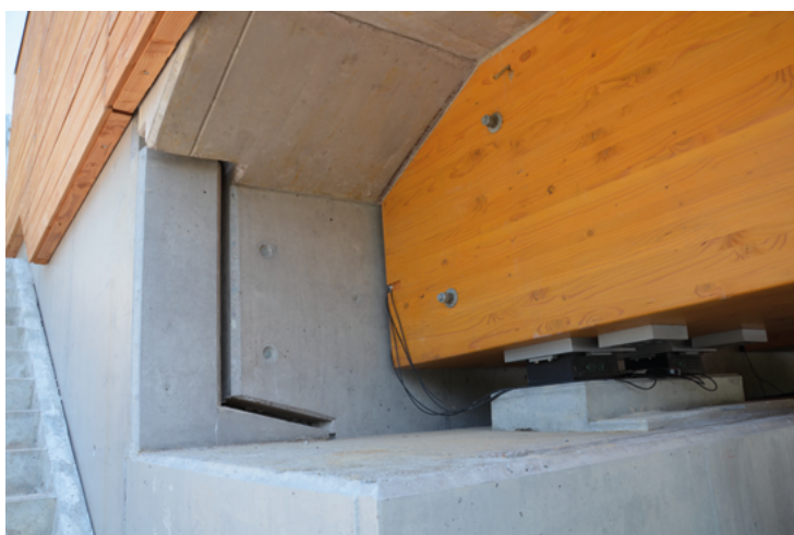
Photo 14 : Détail de la jonction entre la retombée de dalle et le mur latéral de culée (Source : Cerema)
