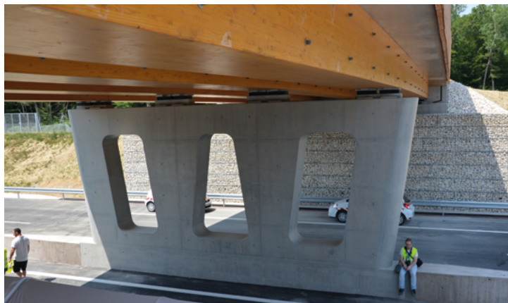
Photo 8 : Exemple de pile intermédiaire (Source : Cerema)
