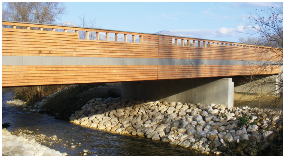
Photo A4 : Élévation générale de l'ouvrage (Source : BG Ingénieurs-Conseils)
