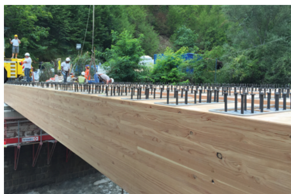
Photo 45 : Nervure équipée de la connexion posée sur ses appuis (Source : Cerema)
