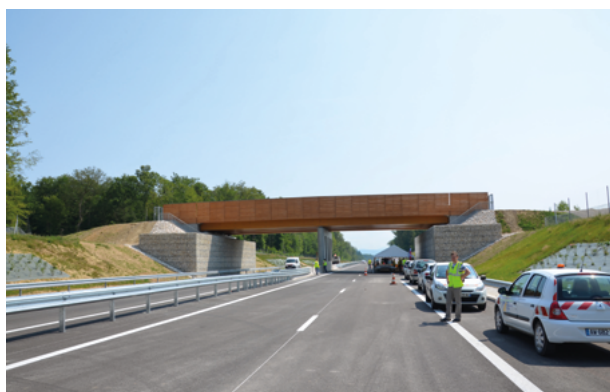
Photos 1 et 2 : Exemple de pont mixte bois – béton à nervures sous chaussée – PS12 de la RN19 – Mise à 2x2 voies de la section Amblans – Lure (Sources : Cerema)
