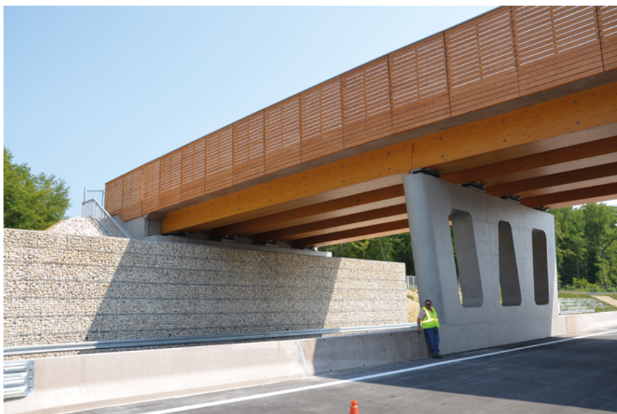
Photo 24 : Exemple d'une pile à parement lisse en béton avec évidement et d'une culée à parement de pierres appareillées (Source : Cerema)
