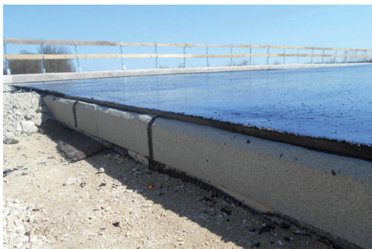
Photo 21 : Continuité de la feuille sur la retombée de dalle et protection de la feuille par un asphalte gravillonné sur la face supérieure du hourdis (Source : DIR Est)
