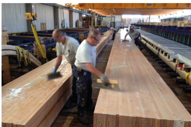
Photo 31 : Encollage des poutres unitaires en bois lamellé-collé (Source : Cerema)
