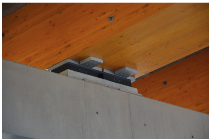
Photo 19 : Emplacements de vérinage sur pile (Source : Cerema)
