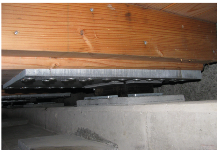
Photo A7 : Appareil d'appui sur culée (Source : Cerema)
