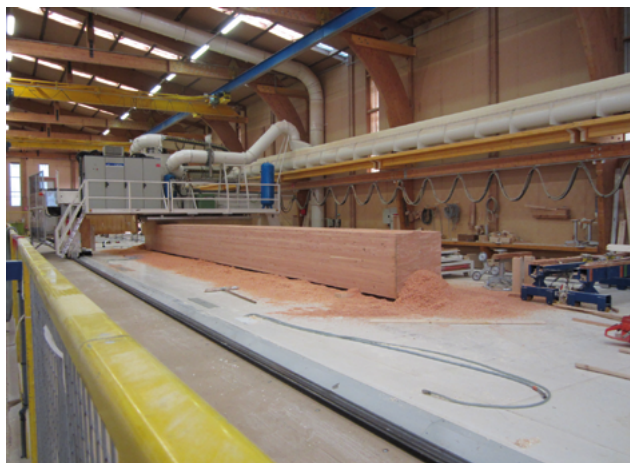
Photo 10 : Rabotage automatique de la face supérieure des nervures en bois (Source : Arbonis)
