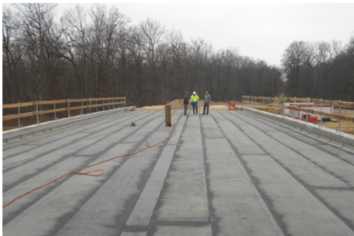
Photo 20 : Étanchéité par feuille préfabriquée (Source : DIR Est)
