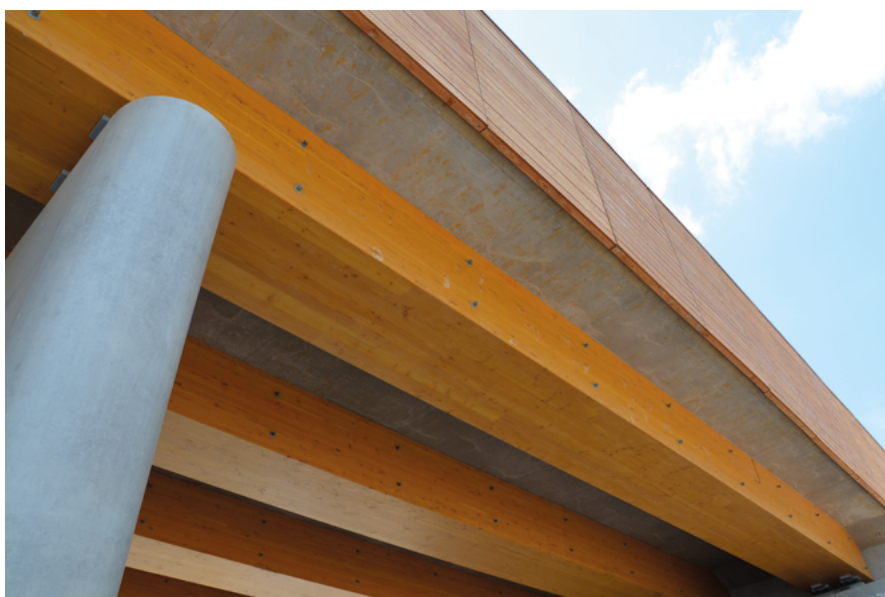
Photo 23 : Perception de la forme des nervures en bois au passage sous l'ouvrage (Source : Cerema)
