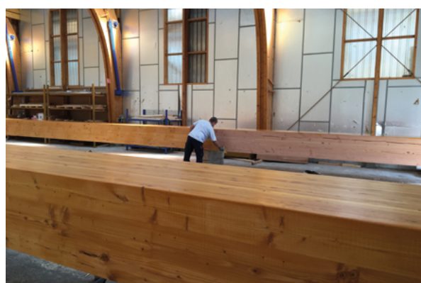
Photo 38 : Lasurage des blocs (Source : Cerema)
