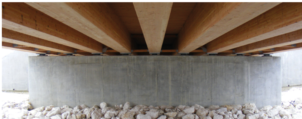
Photo A5 : Vue de l'intrados du tablier (Source : Cerema)
