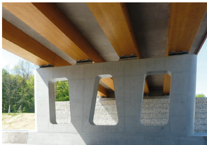
Photo A14 : Vue de la pile centrale (Source : Cerema)
