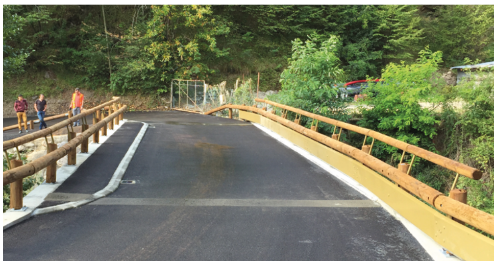
Photo A2 : Vue de la chaussée sur ouvrage (Source : Nice Côte d'Azur Métropole)
