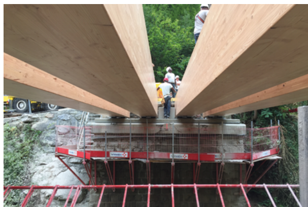
Photos 3 et 4 : Exemple de nervures en bois assemblées par collage de poutres unitaires (À gauche : Source Cerema, à droite : source Nice Côte d'Azur Métropole)
