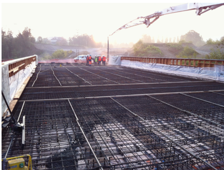
Photo 12 : Bétonnage en place du hourdis (Source : BG Ingénieurs-Conseils)
