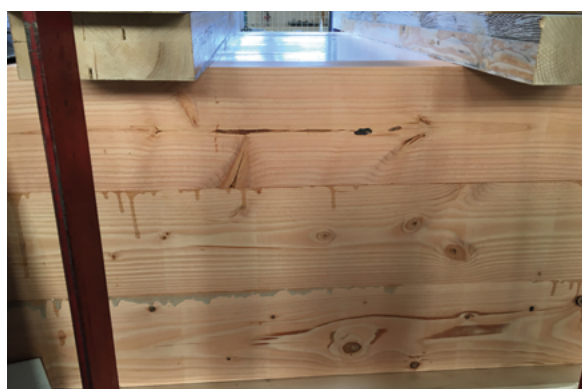
Photo 36 : Détail d'un bloc de trois poutres unitaires sous presse (Source : Cerema)
