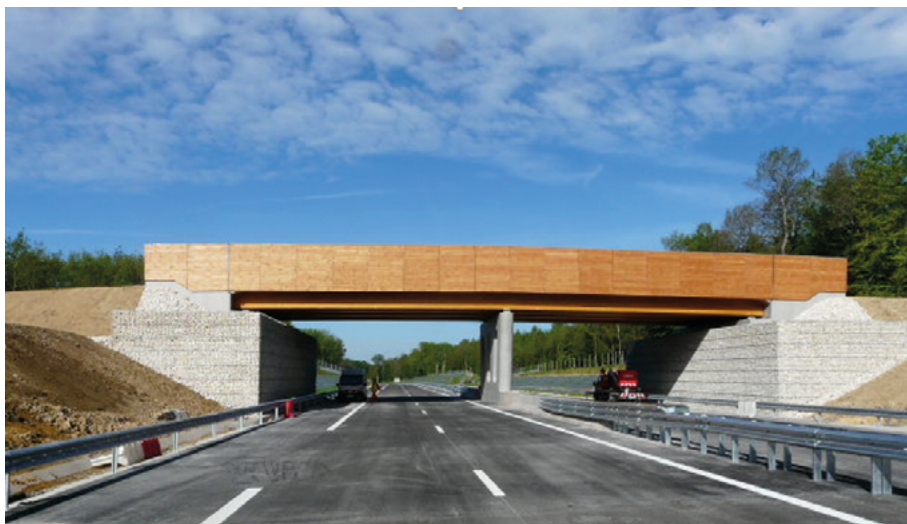
Photo 22 : Silhouette générale d'un pont mixte bois/béton avec palissade bois (passage faune) (Source : Cerema)
