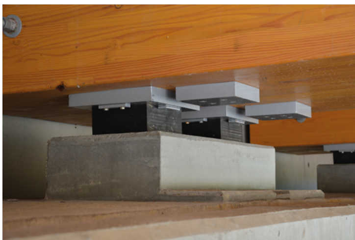
Photo 17 : Détail des appareils d'appui avec plaques de répartition (ici une plaque par appareil d'appui) (Source : Cerema)
