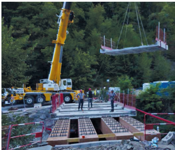
Photo 11 : Mise en place à la grue des dalles préfabriquées avec réservations pour connexion aux nervures en bois (Source : Nice Côte d'Azur Métropole)
