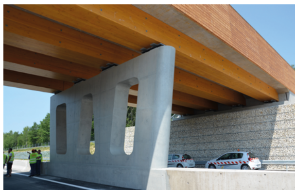
Photos 1 et 2 : Exemple de pont mixte bois – béton à nervures sous chaussée – PS12 de la RN19 – Mise à 2x2 voies de la section Amblans – Lure (Sources : Cerema)
