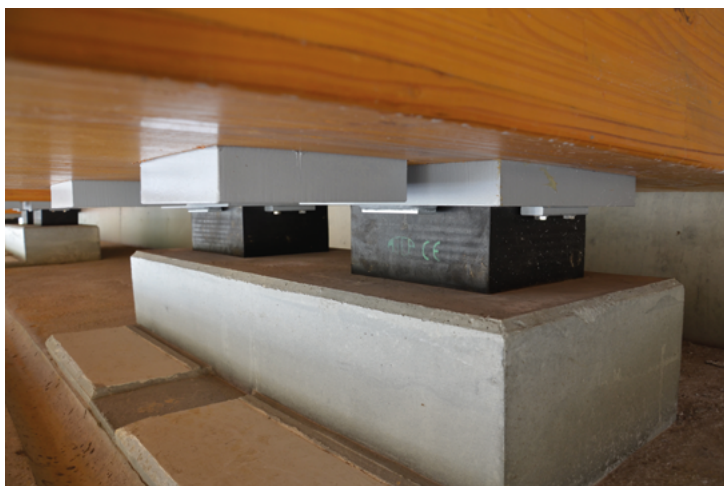
Photo 18 : Emplacements de vérinage sur culée (Source : Cerema)
