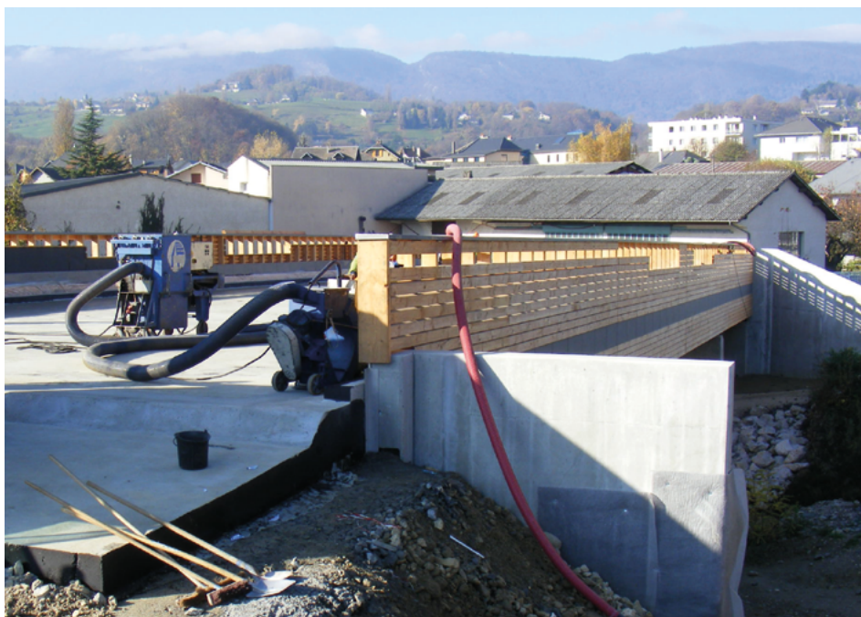
Photo 15 : Dalle de transition de la culée semi-intégrale (Source : BG Ingénieurs-Conseils)
