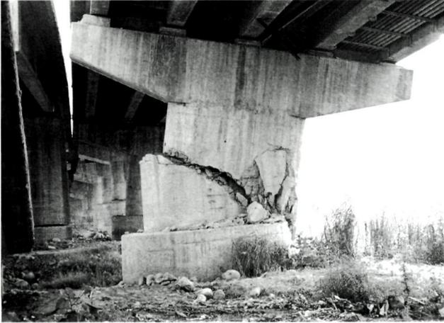
***...et permettre le développement de rotules plastiques,***
