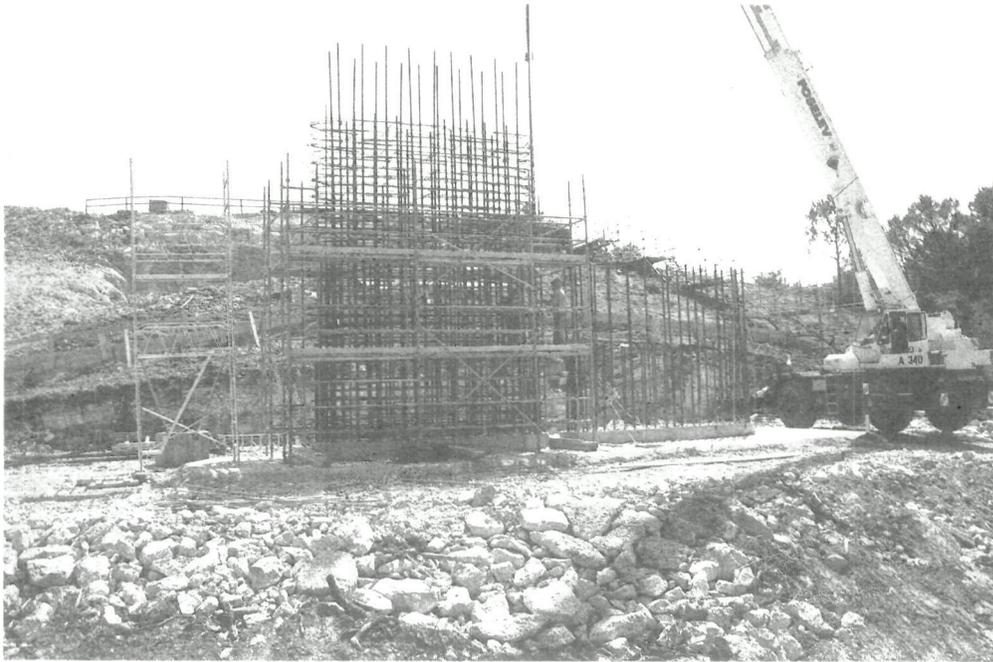
**Les dispositions constructives prévoient un ferrailage minimal important.**
