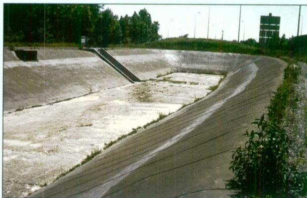
Géomembrane sur l'ensemble de l'ouvrage - protection du fond en béton.
