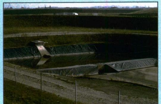
En haut, bassin de temps sec (ou faible pluie) ; en bas, grand bassin régulateur ; protection de la géomembrane en fond, par béton
