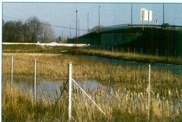
Géomembrane non protégée en talus - protection granulaire en fond - faible lame d'eau semi-permanente.
