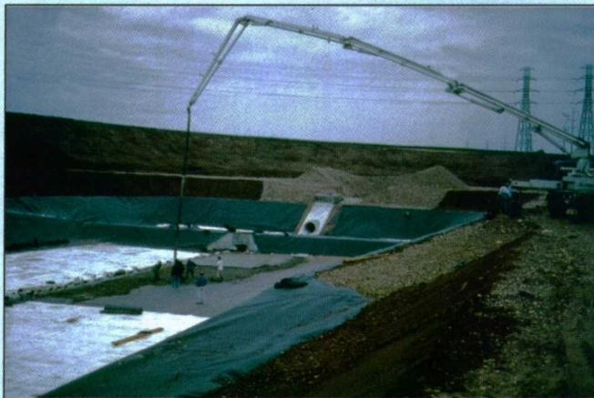
*Mise en place d'une structure de protection en béton fibré en fond de bassin*
