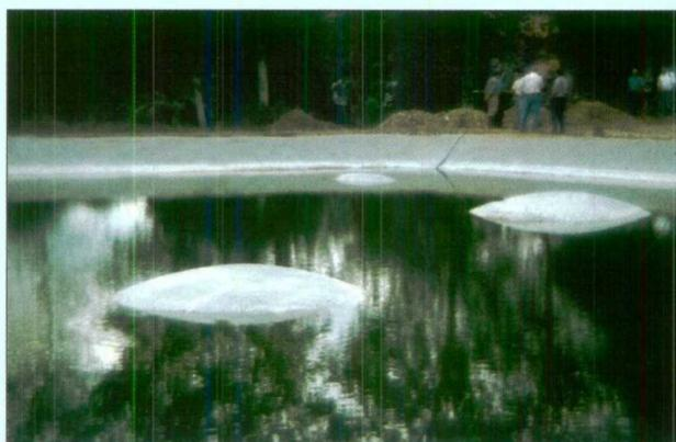
Gonflement de géomembrane en fond de bassin dû à un mauvais drainage de gaz.
