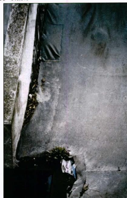
Tassement du support près d'ouvrages en béton entraînant des déchirures de la géomembrane au droit des fixations.
