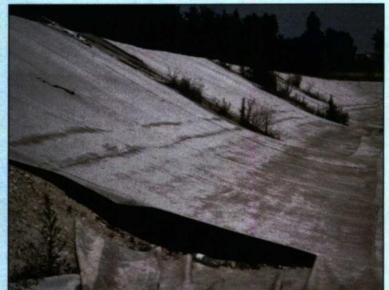
peu supérieures au minimum (1 mm) exigé par la norme NF P 84-500 – l'épaisseur un peu supérieure pour le PEHD est justifiée par une difficulté de réaliser de bonnes soudures de manière régulière avec des épaisseurs plus faibles. A noter que pour tout type de géomembrane, des épaisseurs plus fortes améliorent l'ensemble des fonctions et en particulier la durabilité.
