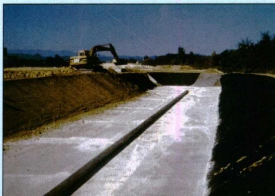
Géomembrane protégée en fond de bassin par structure béton et en talus par de la terre végétale sur géocomposite.
