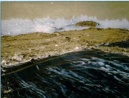
Glissement d'une structure de protection en talus qui nécessite un bon dimensionnement. (vue du haut du talus)
