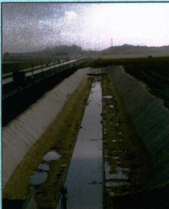
Bassin linéaire - géomembrane raccordée à un canal central en béton - rampe d'accès au fond
