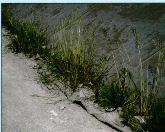
Géomembrane en talus non protégée - protection en fond par structure en béton ; une légère remontée de celle-ci en talus aurait facilité l'entretien
