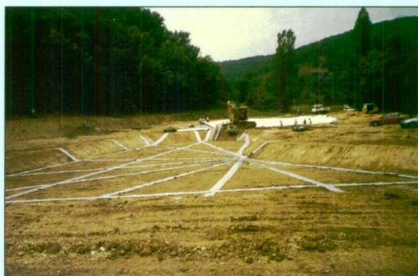
Drainage de gaz sous la géomembrane par bandes de géocomposite.
