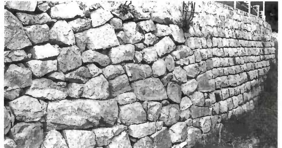
Mur en maçonnerie de pierres sèches
