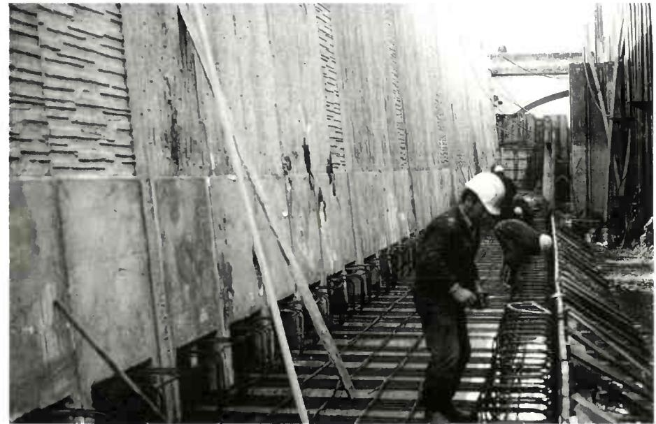
*Mur en béton armé encastré sur semelle (mur partiellement préfabriqué)*
