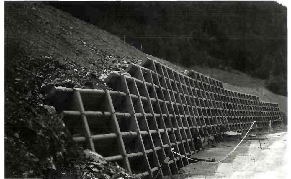
*Mur en éléments préfabriqués en béton empilés (procédé DELTA)*
