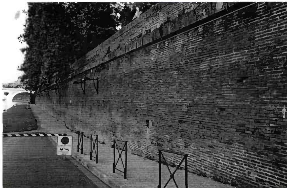
*Mur en maçonnerie de briques jointoyées*
