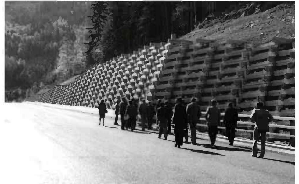
*Mur en éléments préfabriqués en béton empilés (procédé PELLER)*
