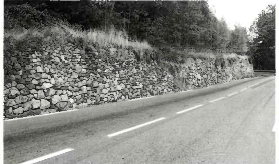
*Mur en maçonnerie de pierres sèches (protégeant la voie)*
