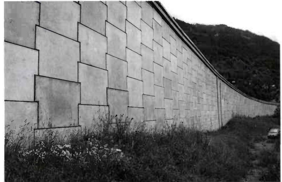
Mur en remblai renforcé par éléments géosynthétiques (procédé FREYSSISOL)
