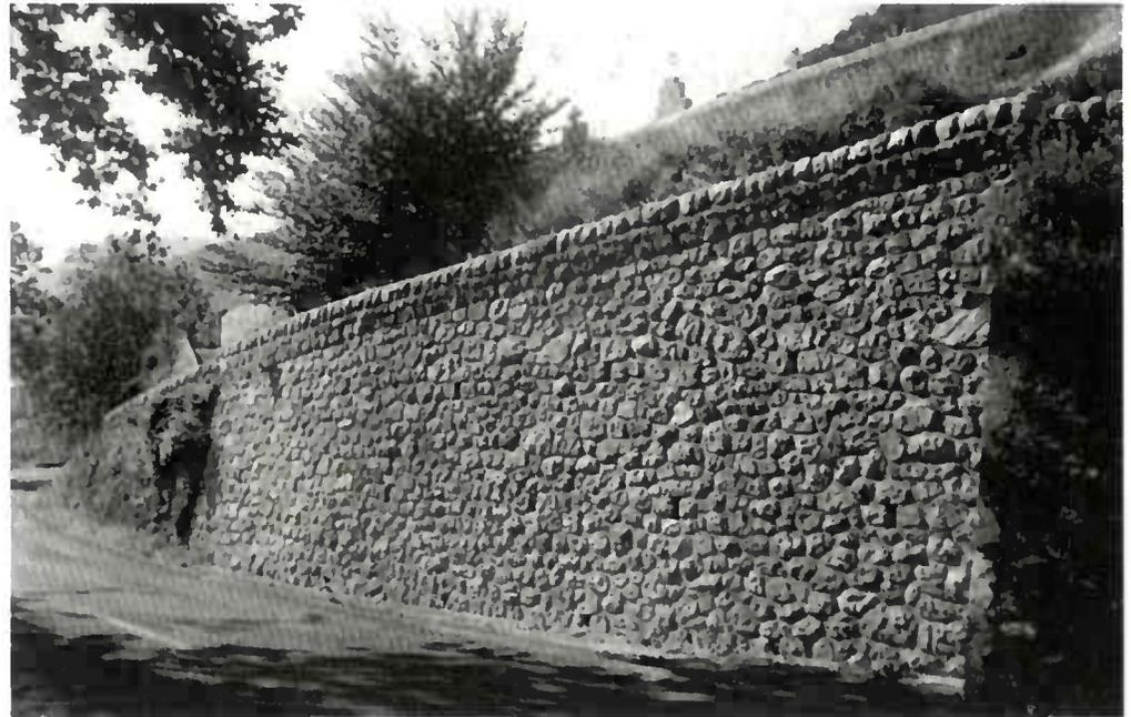
*Mur en maçonnerie de pierres jointoyées*
