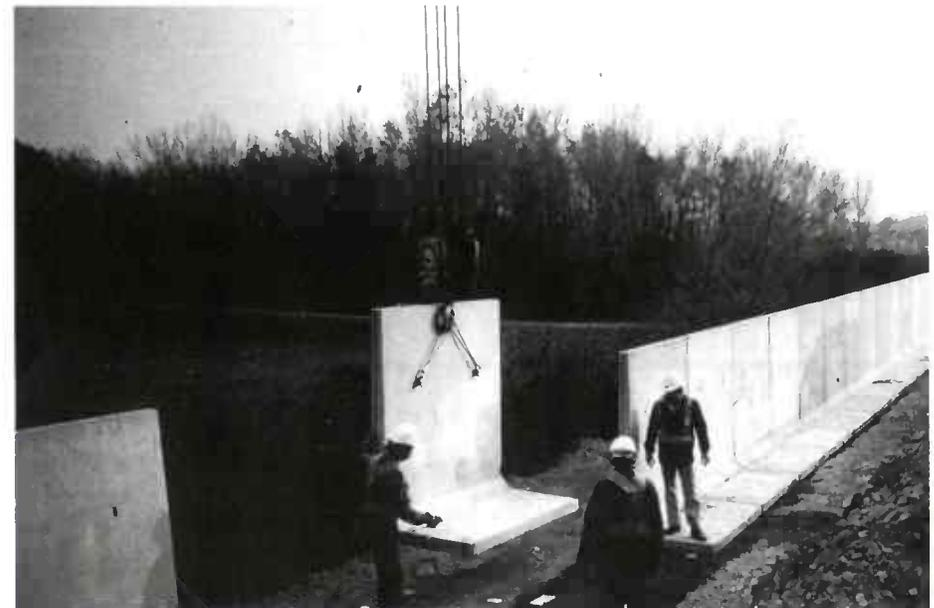
*Mur en béton armé encastré sur semelle (mur totalement préfabriqué)*
