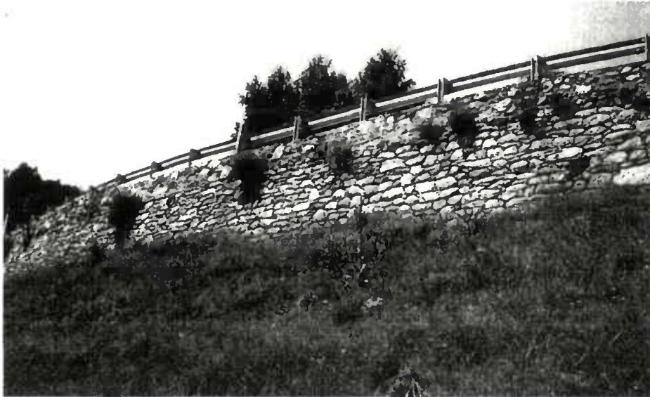
*Mur en maçonnerie de pierres sèches (soutenant la voie)*
