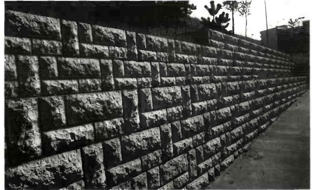
*Mur en éléments préfabriqués en béton empilés (procédé STATER)*
