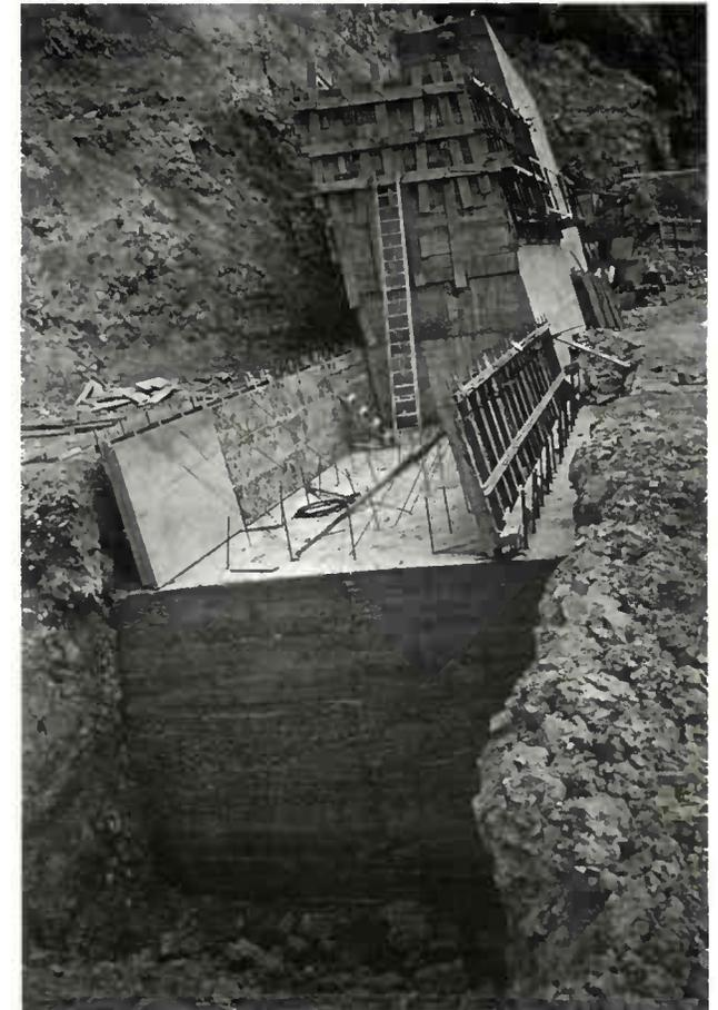
*Mur poids en béton*
