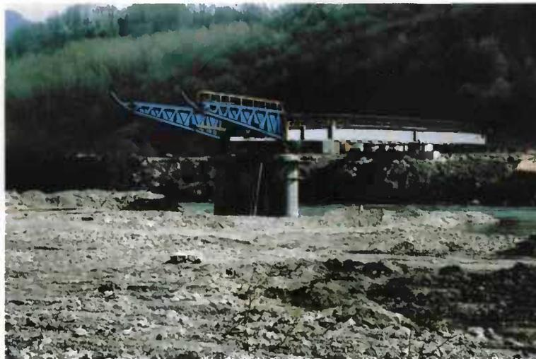
*Figure 178 - Lançage d'un ouvrage métallique - avant-bec*
