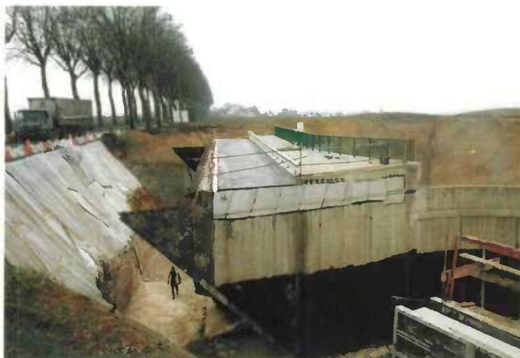
*Figure 184 - demi-tablier prêt à être déplacé*
