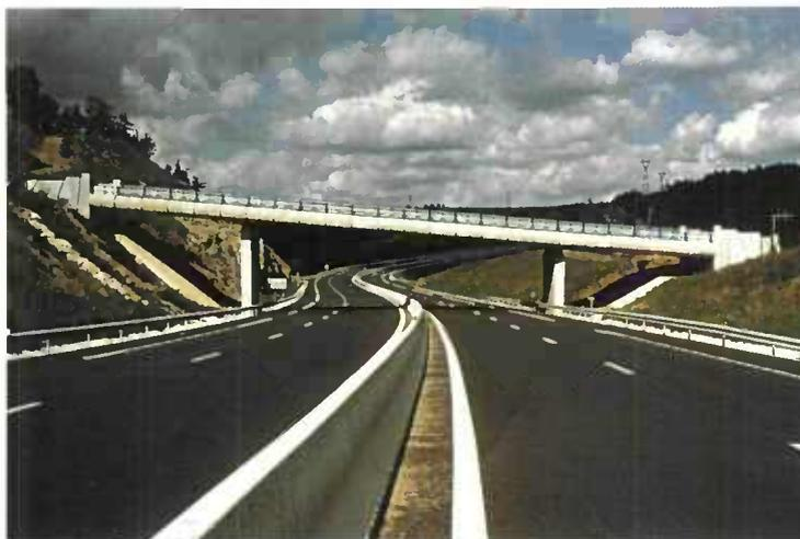
Figure 26 - Un passage supérieur en pente unique
