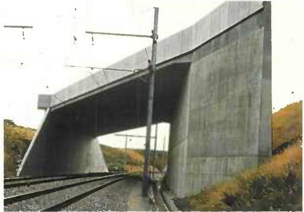
Figure 13 - PIPO biais à 30 grades
