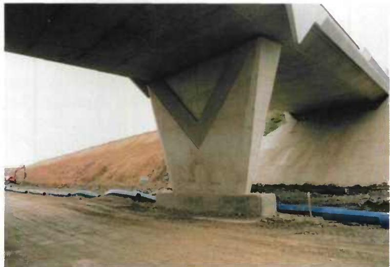
Figure 166 - Formes simples et fonctionnelles dérivées de la section rectangulaire
