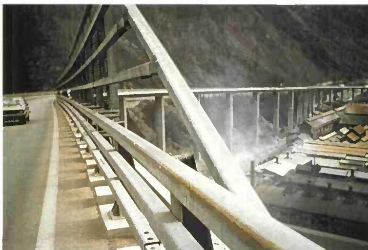
Figure 63 - Dispositif anti-déversement de chargement
