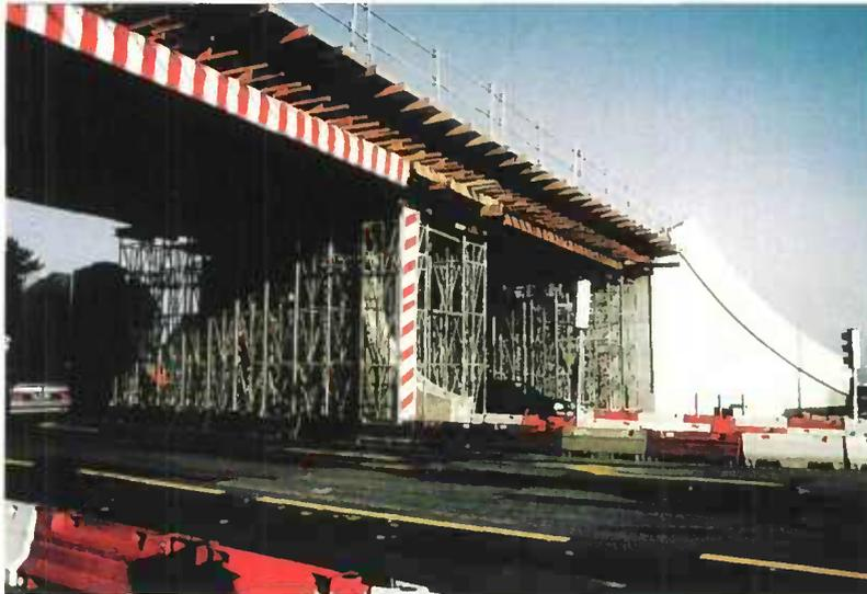
*Figure 142 - Maintien des circulations pendant les travaux*
