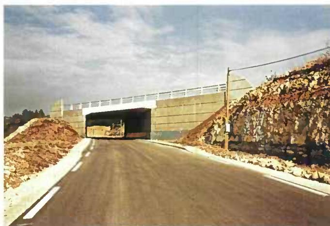
Figure 21 - Passage inférieur biais
