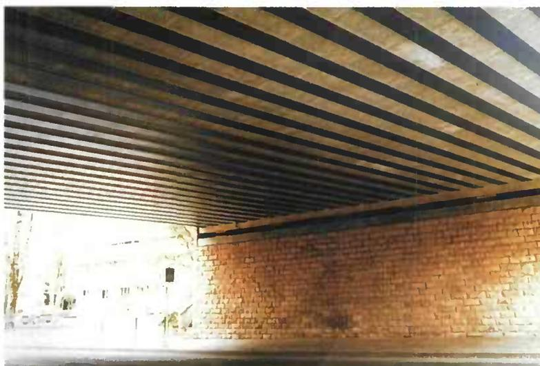
Figure 214 - Pont à poutrelles enrobées
