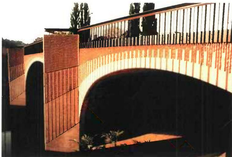
*Figure 153 - Le béton n'est pas forcément lisse et fade. En le désactivant ou en cassant des cannelures en surabondance, on obtient un parement riche et animé*
