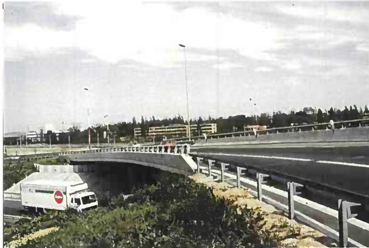
Figure 57 - Raccordement d'une glissière métallique sur une barrière BN2
