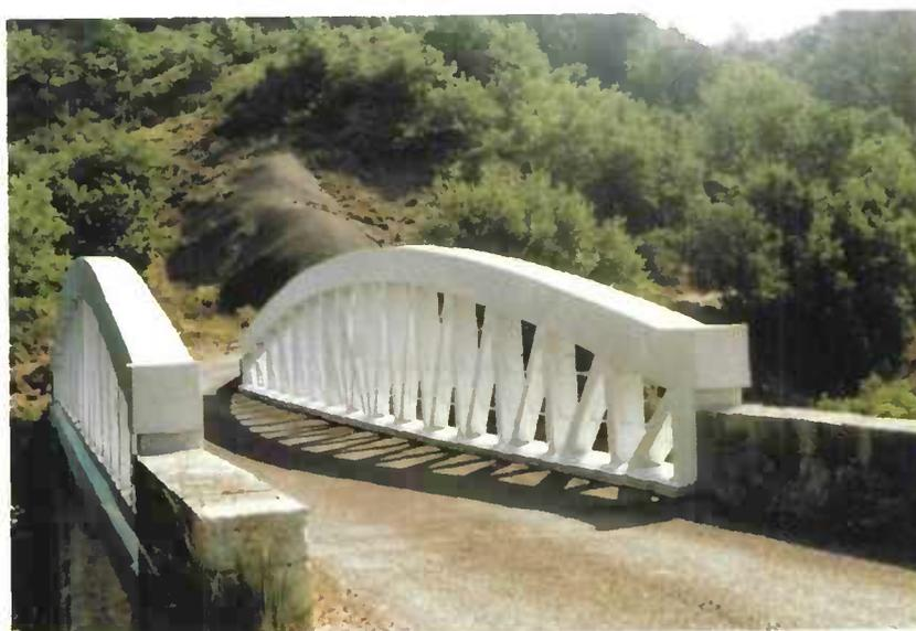
Figure 193 - Pont à poutres latérales
