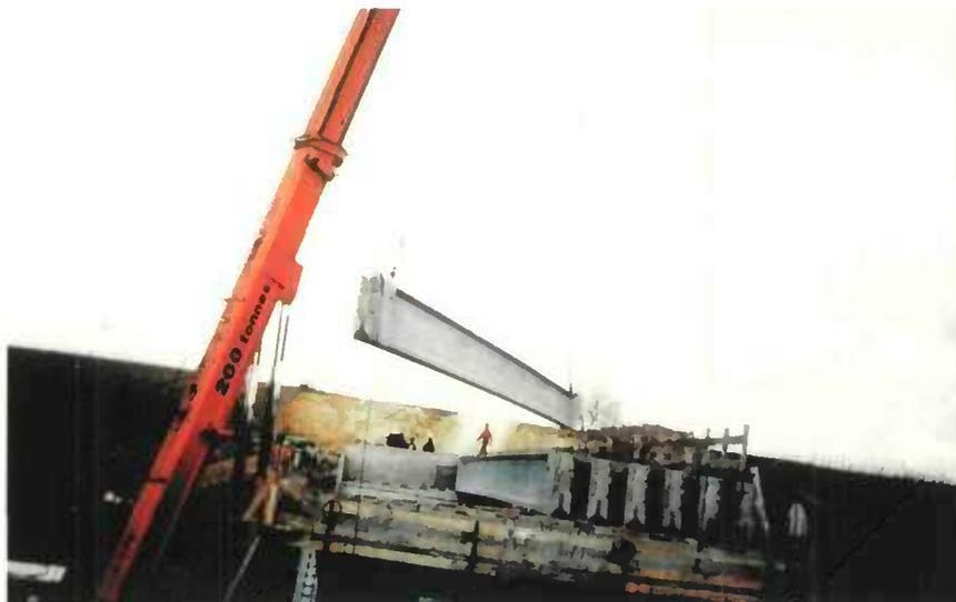
*Figure 175 - Pose de poutres PRAD à la grue*
