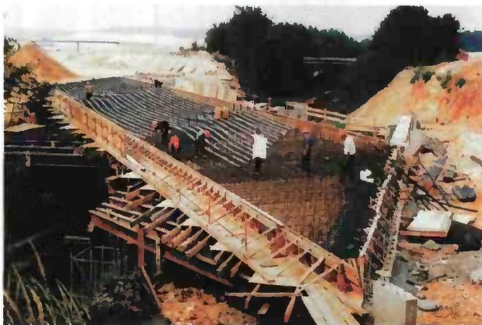
Figure 168 - Dalle précontrainte sur étaiements en cours de ferrailage
