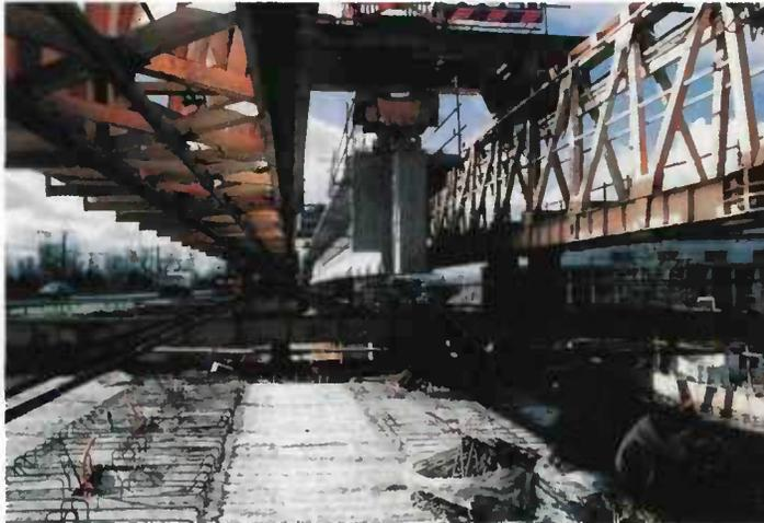
Figure 174 - Lancement d'une poutre VIPP
