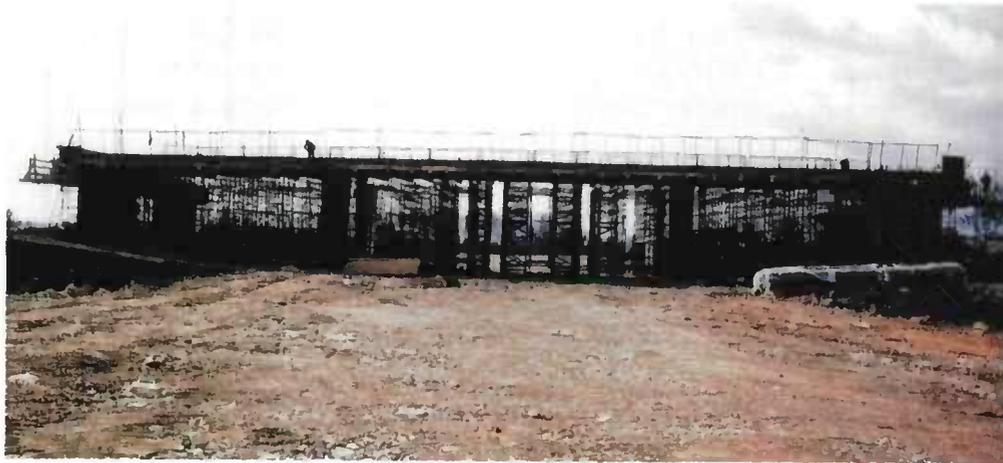
*Figure 170 - Echafaudage général d'un pont dalle*
