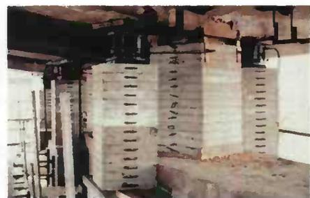
Figure 172- Construction en sur-gabarit - Empilement de cales en béton
