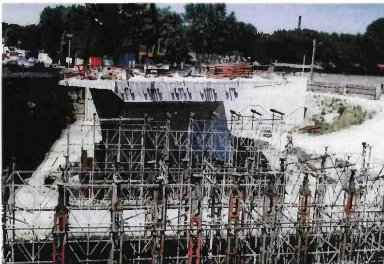
*Figure 181 - Phasage longitudinal - Section de reprise*
