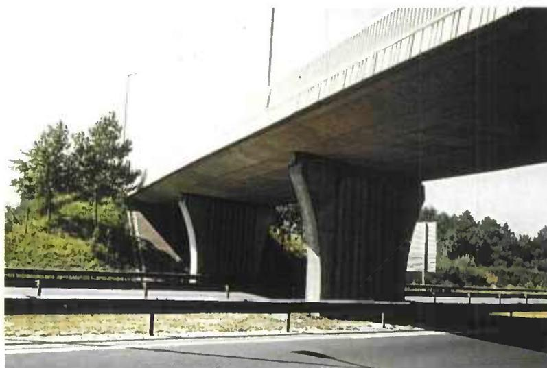
Figure 205 - Exemple de pont dalle
