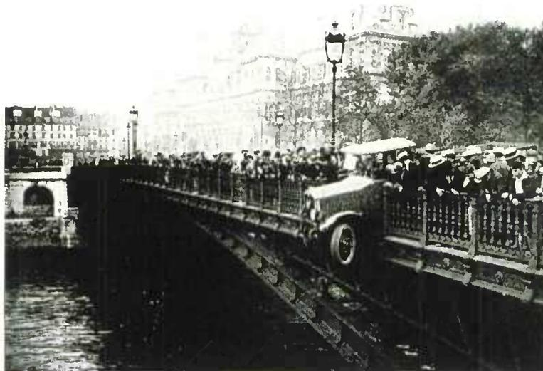
Figure 92 - Choc de véhicules sur dispositif de retenue
