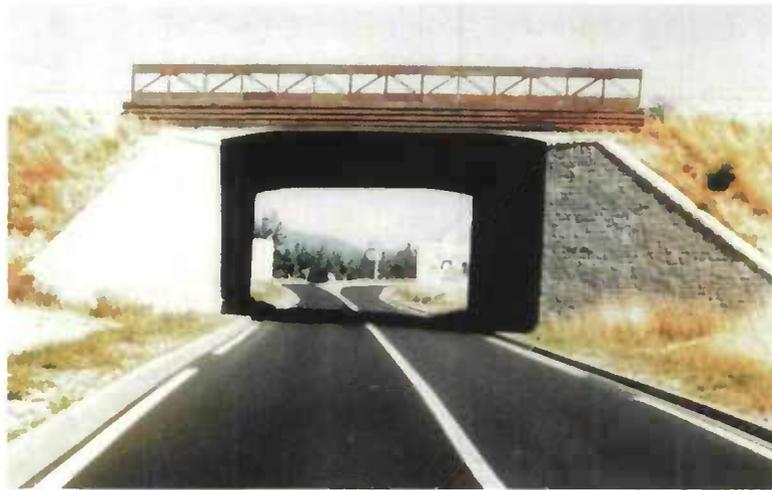
Figure 195 - Pont cadre de type PICF
