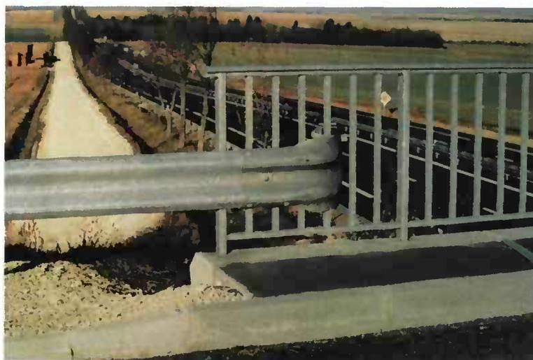
Figure 152 - Le raccordement d'une glissière sur un garde-corps relève souvent du bricolage
