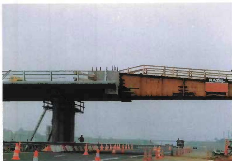
Figure 185 - Poussage d'un pont dalle au dessus d'une voie en service
