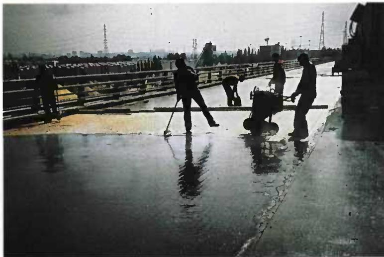
*Figure 87 - Pose d'une étanchéité*
