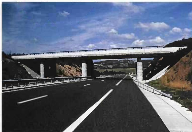
Figure 8 - Un des ouvrages-types les plus courants : Un pont dalle
