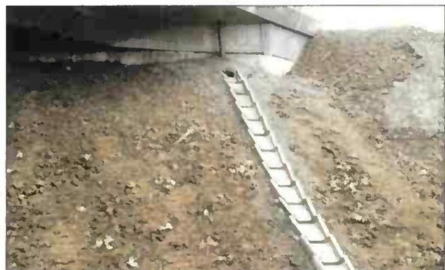
Evacuation des eaux à l'extrémité de l'ouvrage par un avaloir scellé en pied, au départ du caniveau de descente par, tuiles emboîtées, construit sur le perré.
