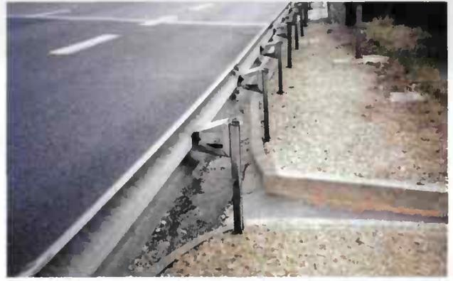
Collecte et raccordement à une descente d'eau.
