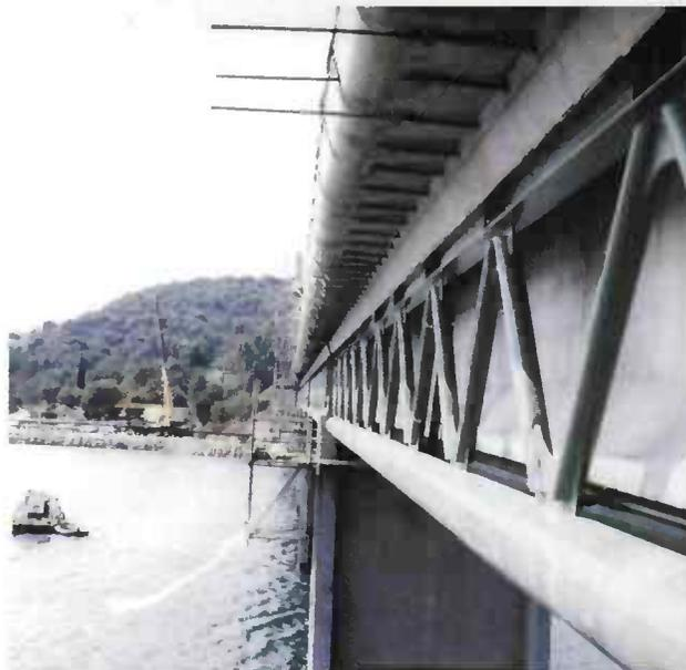
Les désordres engendrés ont nécessité la mise en œuvre d'une réparation générale par poutres en treillis très onéreuse.
