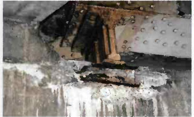
Des arrivées d'eau importantes sur les chevêtres des culées induisent des coulures inesthétiques sur les murs de front et provoquent, par stagnation d'eau, la dégradation du béton armé de toutes les parties arrosées (éclatements du béton, corrosion des armatures, altérations dues aux cycles gel / dégel).
