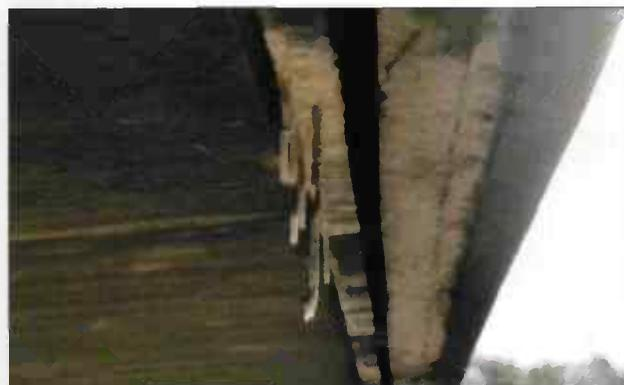
La réalisation d'un larmier ne dispense pas de prendre les dispositions permettant de supprimer la cause des infiltrations d'eau ! Il sera utile de consulter les fiches 14a "défaut d'étanchéité au droit des équipements: ancrages traversants" et 14c "défaut d'étanchéité au droit des équipements: jonction corniche - trottoir".
