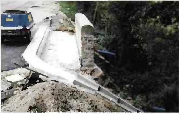
Disposition type de raccordement du fil d'eau à un caniveau de descente par tuiles emboîtées.
