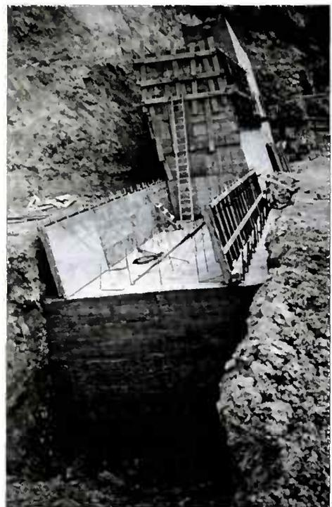
Figure 1.5 : Mur poids en béton
