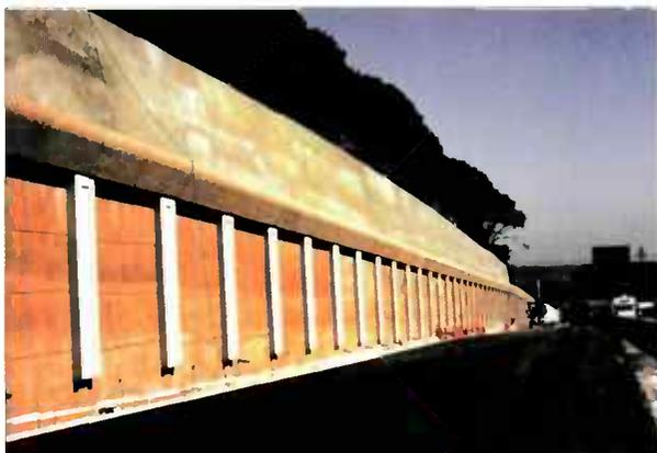
*Figure 2.17 : Parement d'une paroi clouée en béton coloré*
