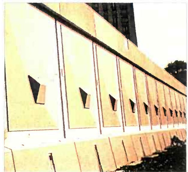
Figure 1.33 : Paroi préfabriquée ancrée
