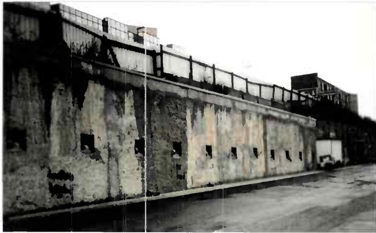
Figure 1.32 : Paroi moulée ancrée par un lit de tirants actifs
