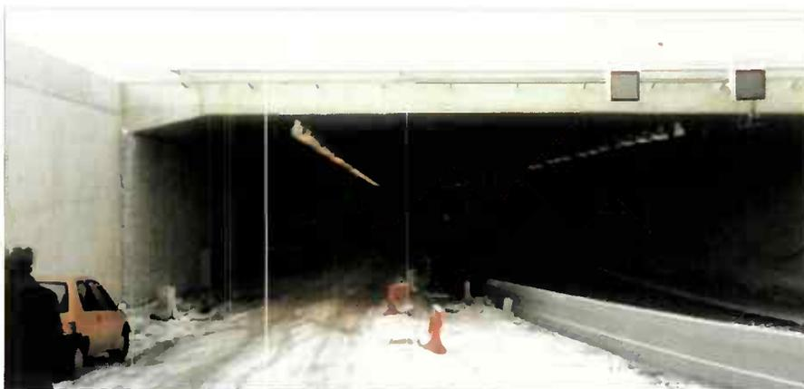
Figure 1.34 : Tranchée couverte avec pîedroits en parois moulées
