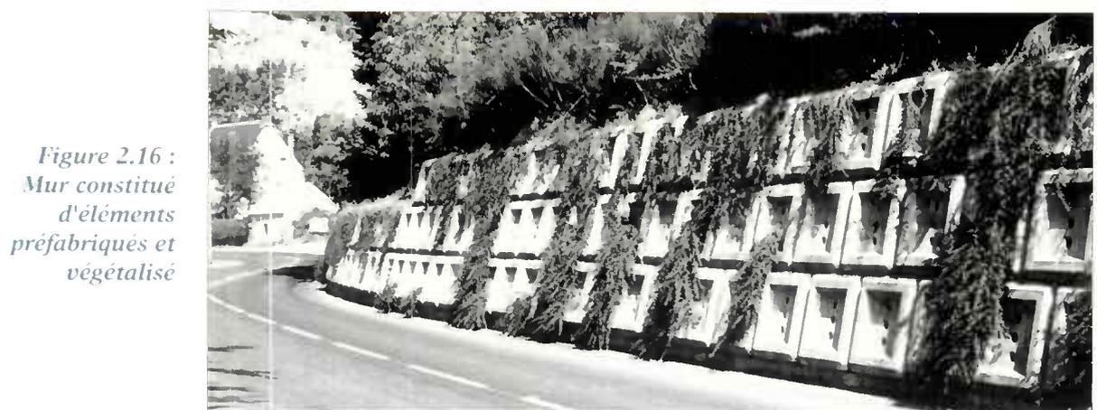
Figure 2.16 : Mur constitué d'éléments préfabriqués et végétalisé
