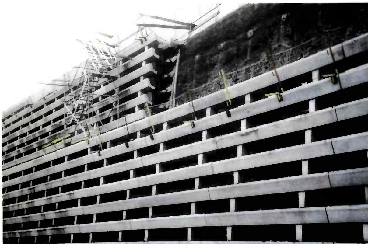
*Figure 2.19 : Eléments préfabriqués mis en place devant une paroi clouée*
