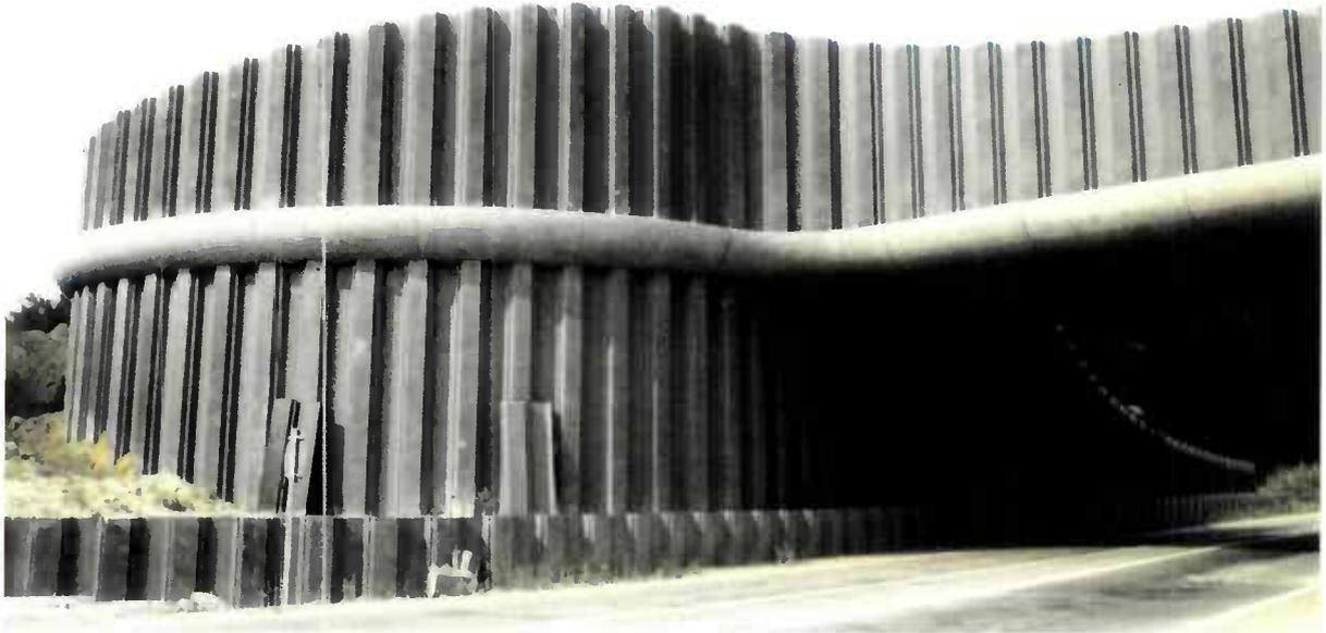
Figure 2.14 : Ouvrage en palplanches présentant une courbure en plan
