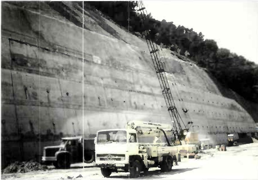
Figure 1.39 : Exécution d'un voile ancré
