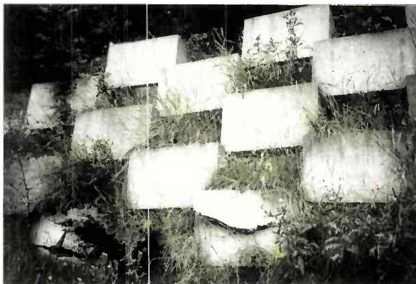
*Figure 2.7 : Rupture d'un élément préfabriqué*
