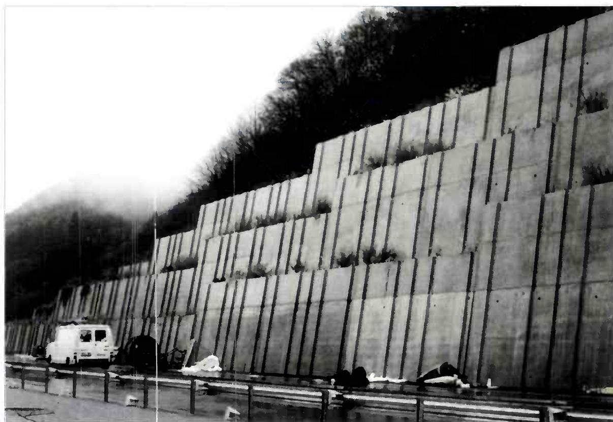
Figure 2.3 : Vue de l'ouvrage ancré avec risbermes
