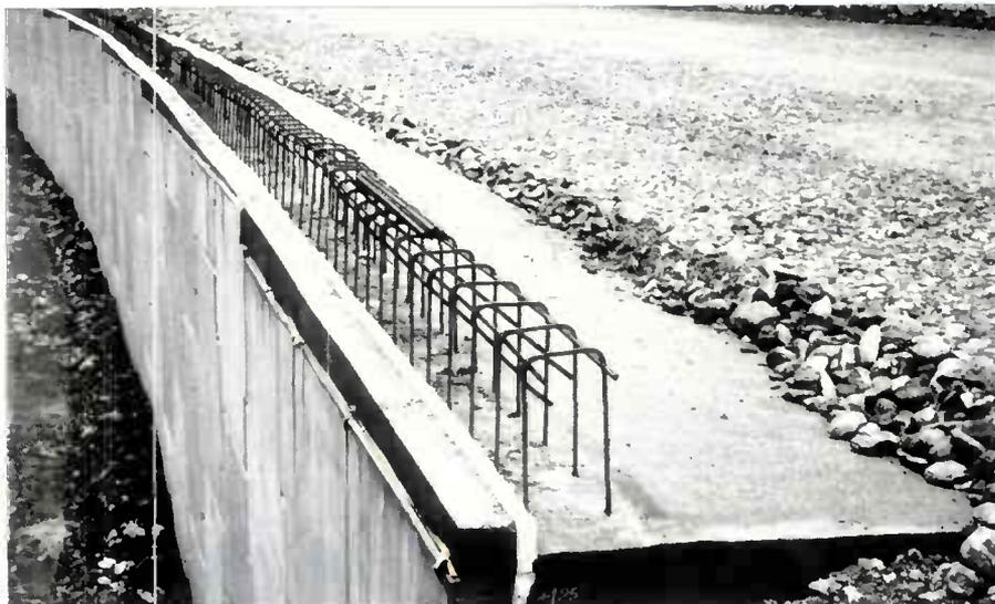
Figure 2.22 : GBA sur dalle de frottement en cours d'exécution
