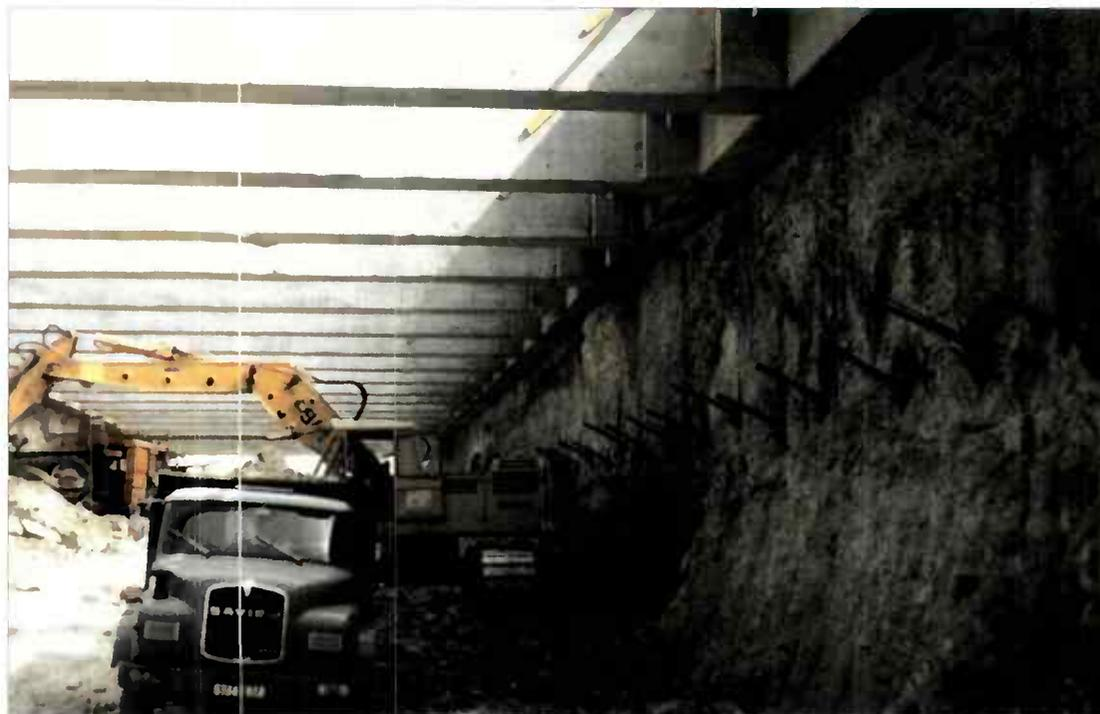
Figure 1.30 : Réalisation d'une tranchée en paroi moulée -
