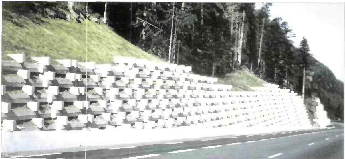
Figure 1.8 : Mur poids constitué de poutres préfabriquées
