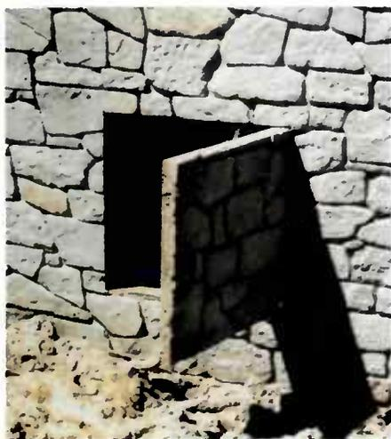
*Figure 2.27 : Trappe de visite dans un parement rapporté (accès à un parement géotextile)*
