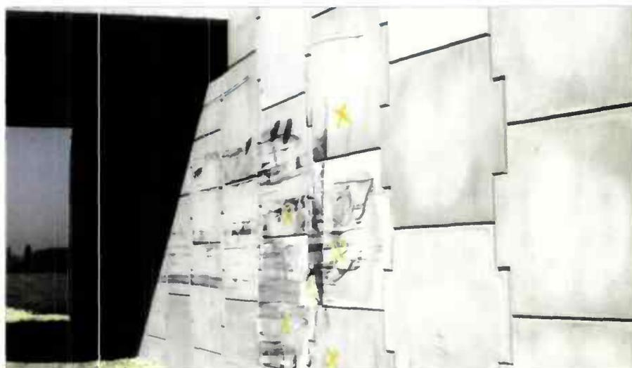
Figure 2.24 : Effet du choc d'un véhicule sur le parement d'un mur en terre armée
