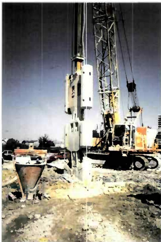
Figure 1.28 : Exécution d'une paroi moulée -
