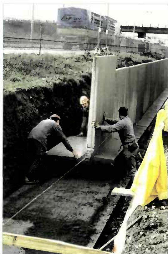
Figure 1.17 : Mur constitué d'éléments préfabriqués
