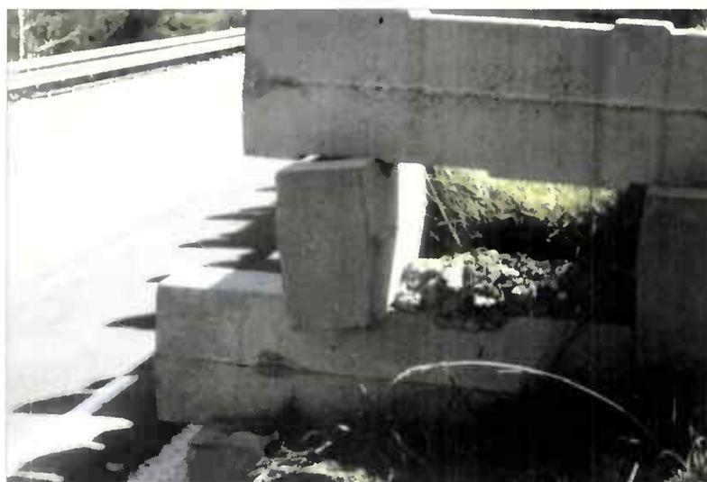
*Figure 2.8 : Basculement d'une poutre*
