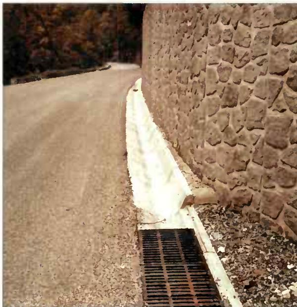
*A noter, la liaison en béton maigre entre le mur de soutènement et le caniveau.*
