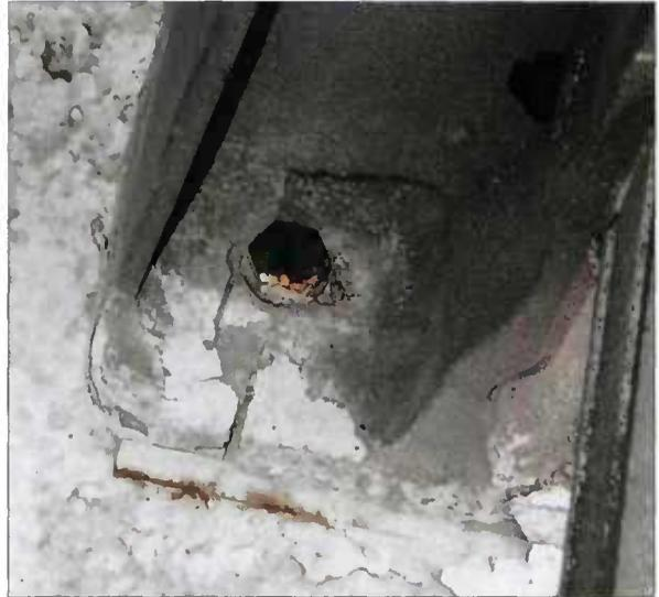
Figure 12 : Corrosion de vis en acier galvanisé fixant des pièces en alliage d'aluminium sans isolation.
