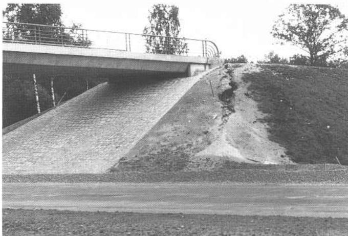
a) Ravinement du remblai à la jonction avec l'ouvrage
