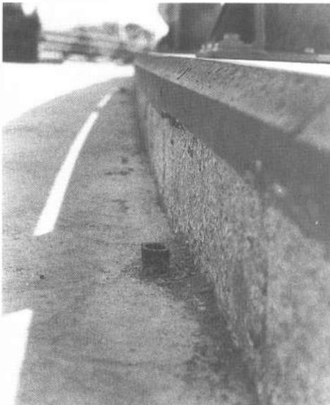
Figure 19 : Tube mis en place lors du bétonnage de la dalle
