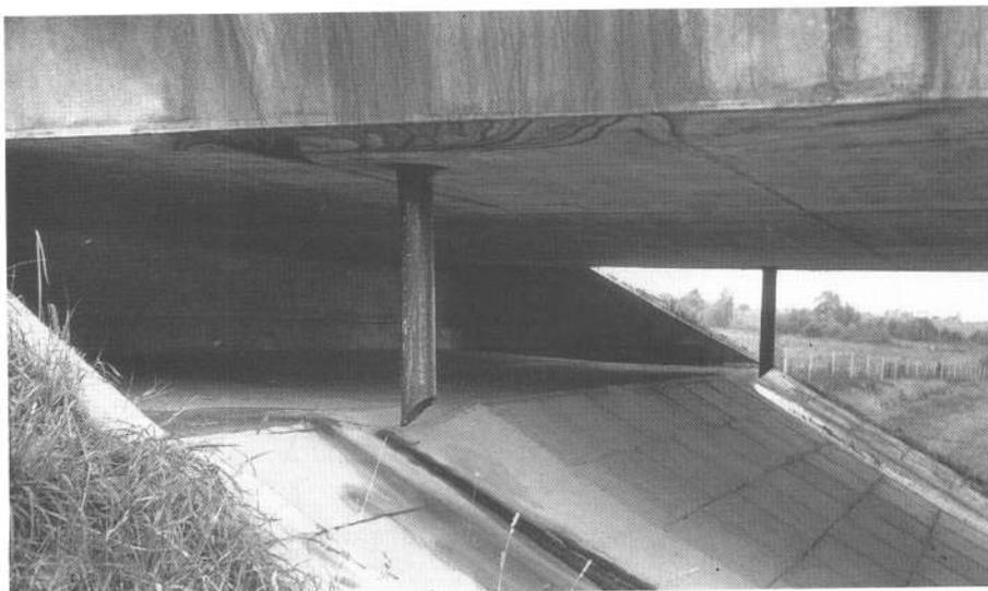
Figure 20 - Principe d'une liaison directe entre l'avaloir et le réseau d'assainissement de la plateforme inférieure
