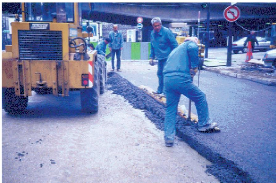
*Préparation manuelle d'un joint longitudinal*
