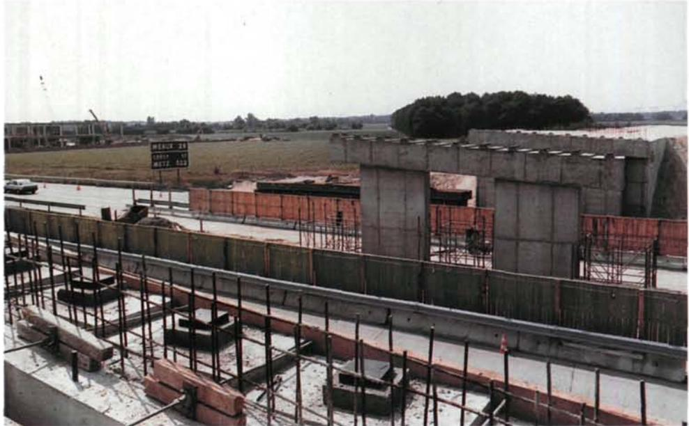
*FIG. 24 : Appuis - Appareils d'appui mis en place sur des bossages*
