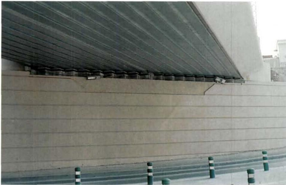
FIG. 27 : Culée et appareils d'appui - Ouvrage fini
