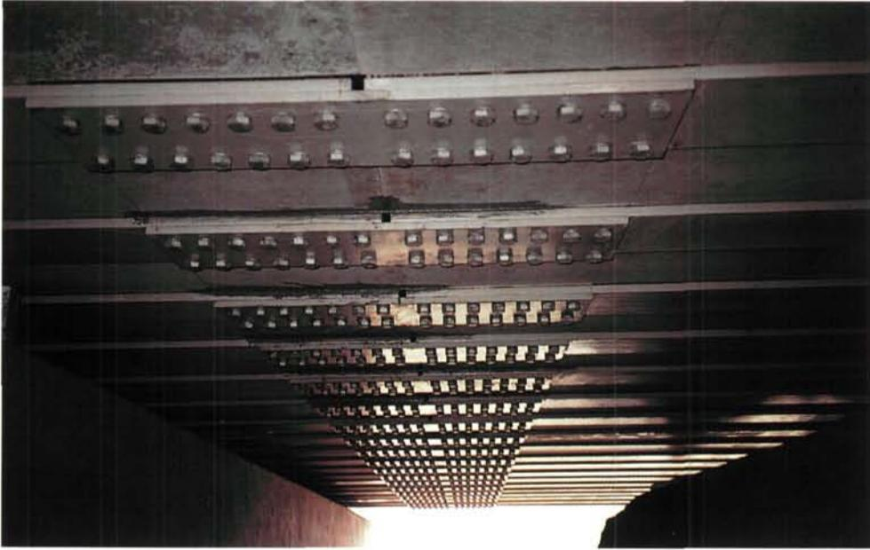
*FIG. 6 : Assemblage par couvre - joint*
