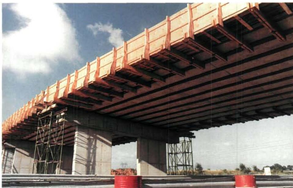
*FIG. 55 : Coffrage des bords libres en encorbellement*
