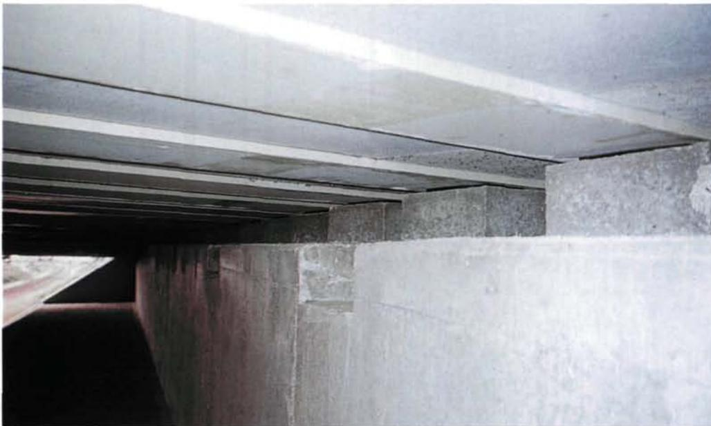
*FIG. 25 : Détail des bossages sous poutrelles*
