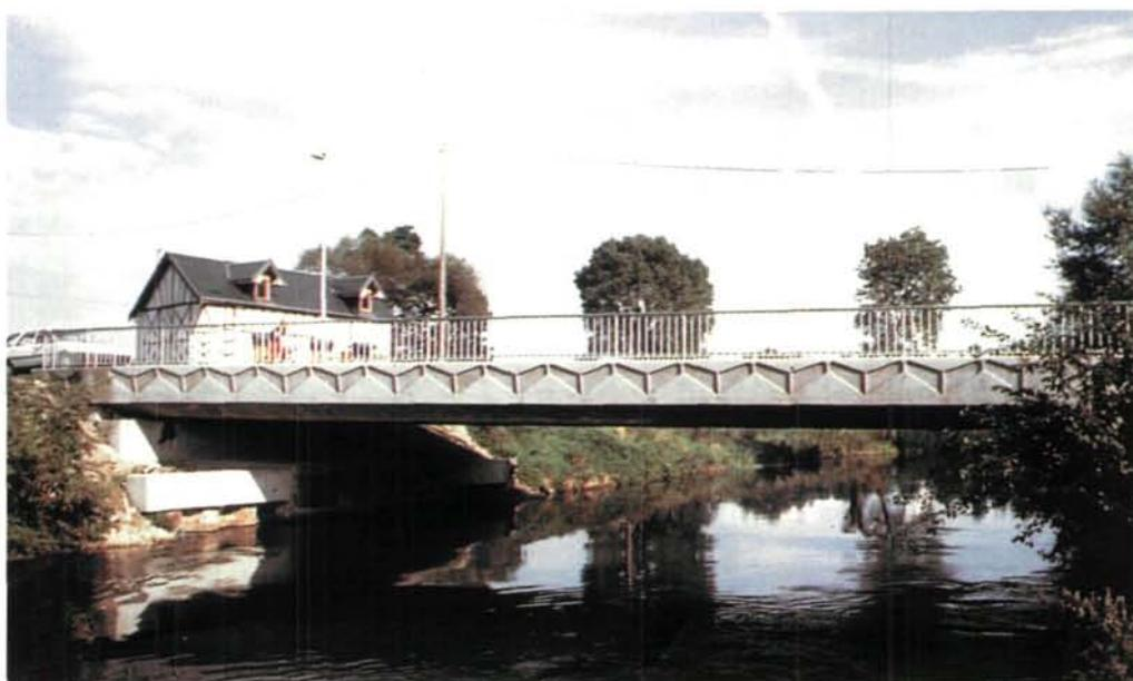
FIG. 45 : Ouvrage hydraulique à poutrelles enrobées
