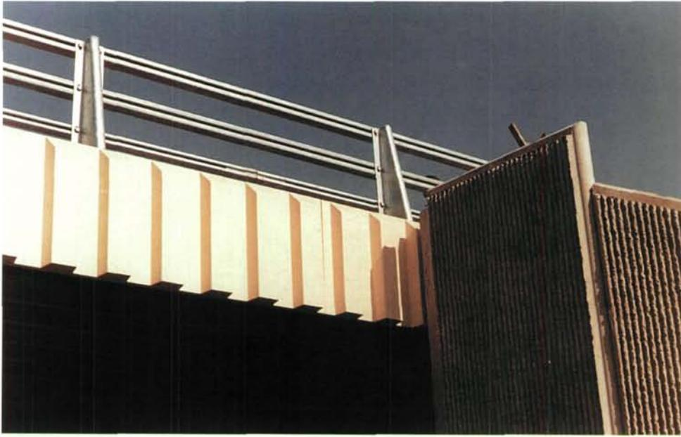
*FIG 46 : Corniches en matériau composite*
