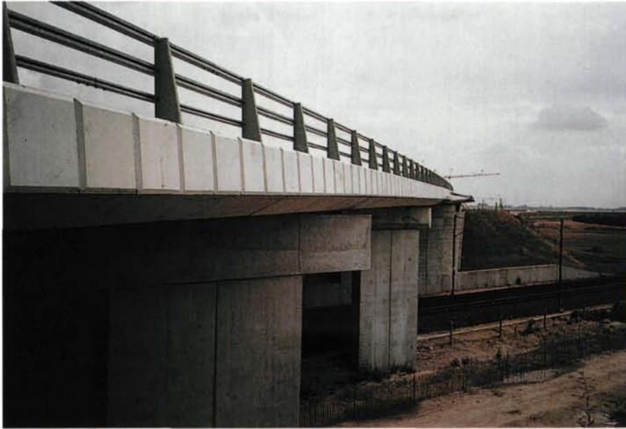
FIG. 35 : Corniches préfabriquées - Ouvrage fini
