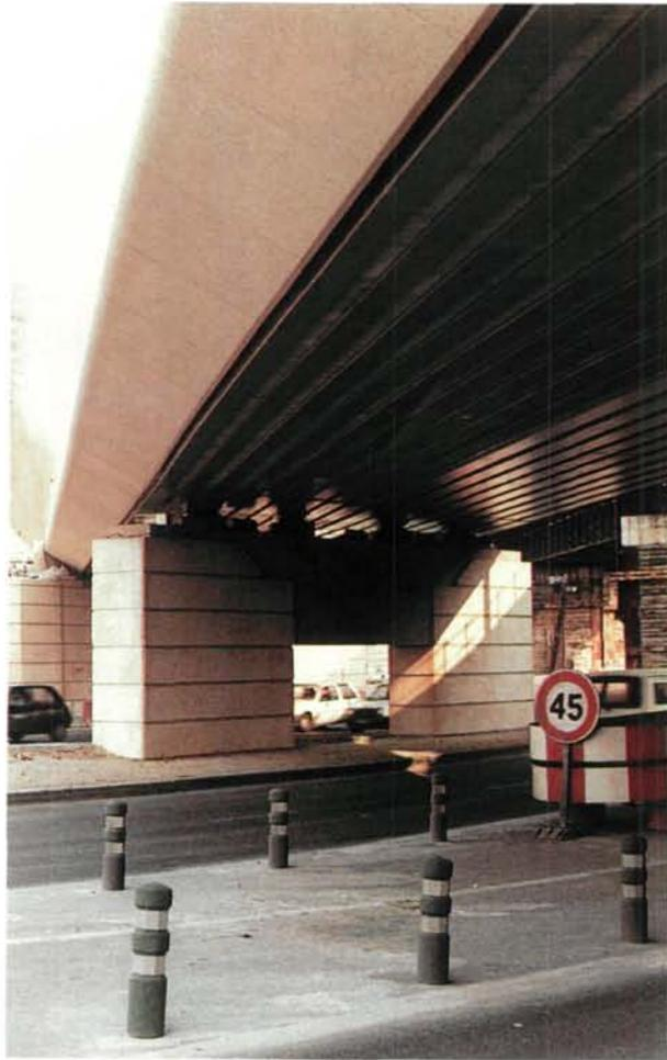
*FIG 47 : Corniches préfabriquées en béton architectonique*
