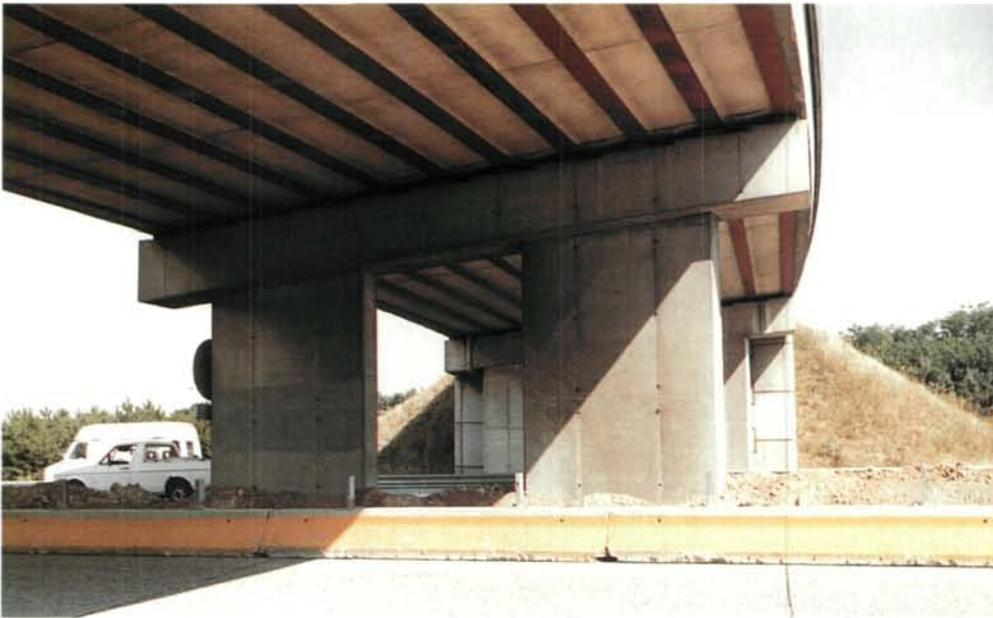
*FIG. 8 : Tablier courbe à poutrelles rectilignes*
