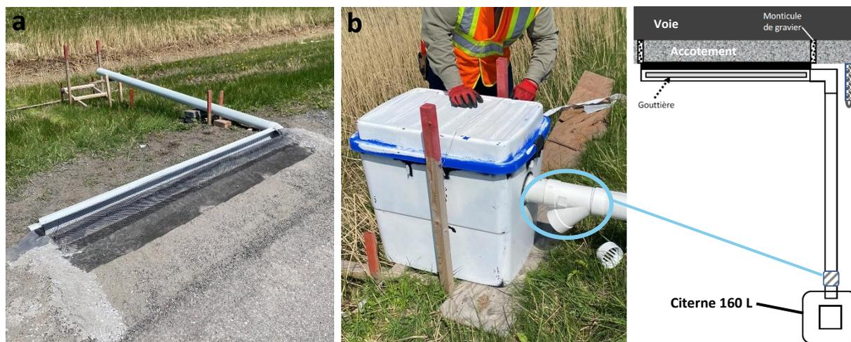
Figure 4. a : gouttière; b : citerne « inactive » avec un dispositif anti-refoulement (cercle en bleu)
