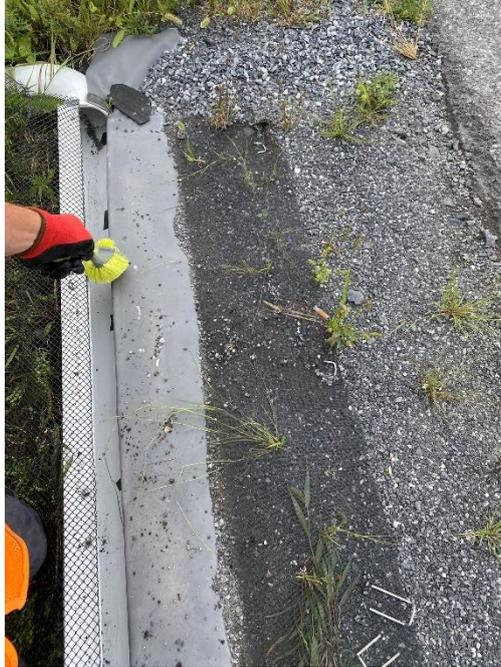
**Figure 15. Nettoyage à la brosse de la géomembrane de la gouttière après un échantillonnage**
