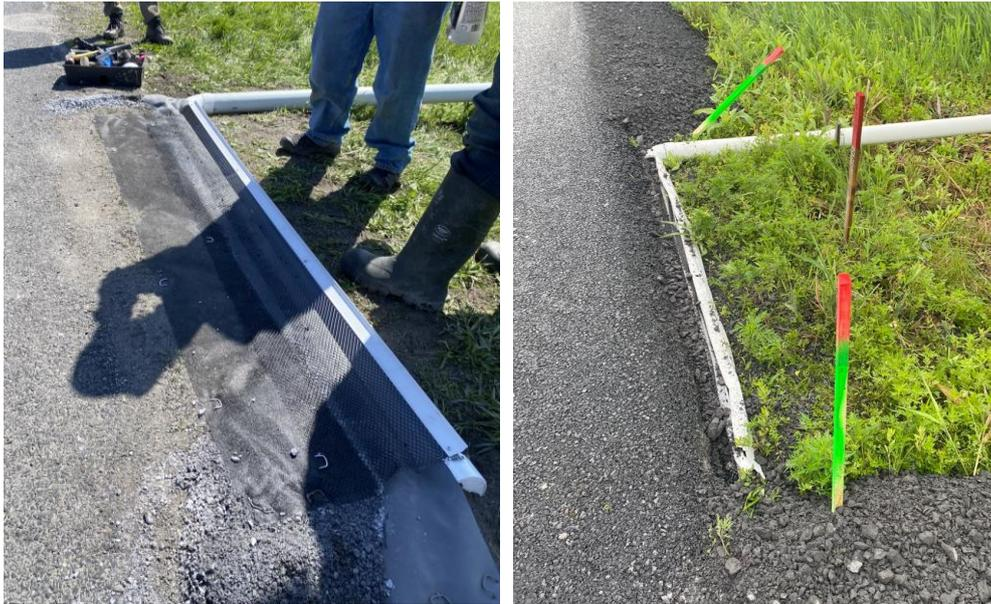
**Figure 26. a : Site M2 avec la géomembrane intacte (photo prise le 08/05/2023); b : Site M2 avec la géomembrane asphaltée (photo prise le 22/07/2023)**
