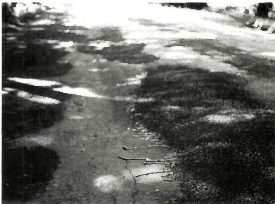
Lorsque l'on répand en premier l'émulsion, on observe souvent des coulures, le pré-gravillonnage "à sec" permet d'éviter cet inconvénient.
