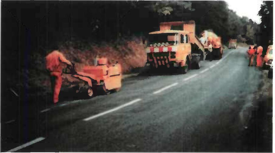
Atelier complet d'imperméabilisation : 1 camion à gravillons, le point à temps, 1 camion à gravillons, 1 compacteur
