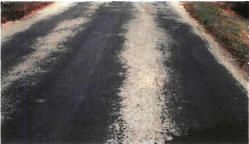
Ressuage généralisé sur enduit nécessitant un cloutage au 4/6 ou 6/10
