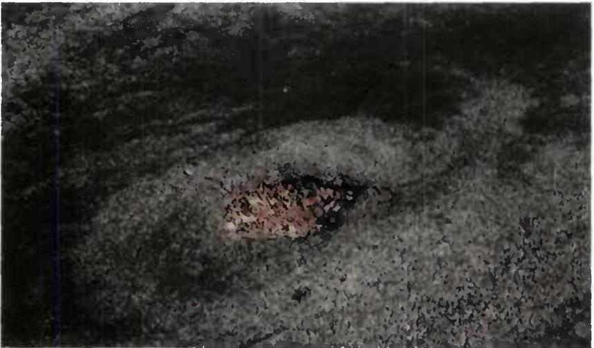
Nid de poule avec faïençage nécessitant une purge superficielle
