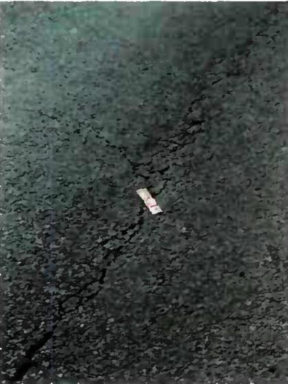
Fissures faïencées à imperméabiliser
