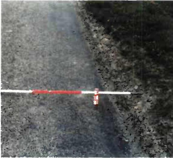
Affaissement de plus de 5 cm nécessitant un reprofilage
