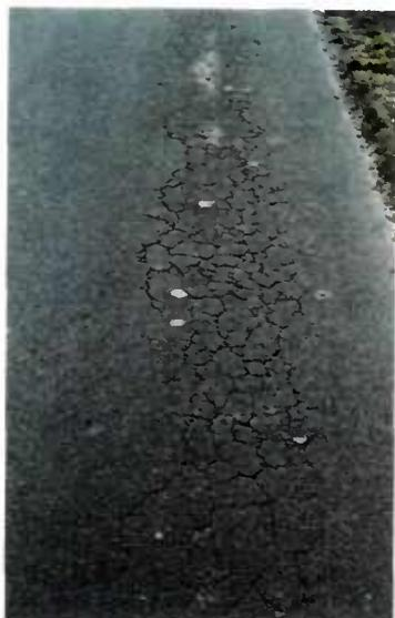
Faïençage nécessitant un scellement et une imperméabilisation
