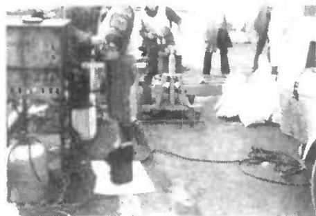
b) Préparation sur chantier du mélange s'il est en mortier de résine, à partir des éléments approvisionnés en sac prédosés.
