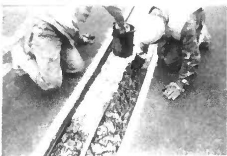
c) Mise en oeuvre de la liaison avec la structure par enduction d'un film de liant pur ou...
