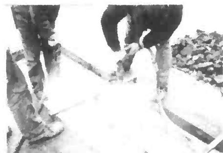
d) ... par aciers scellés dans des trous forés dans le béton.
