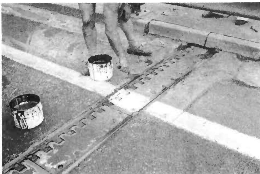
c) Raccordement à l'étanchéité générale. Mise en oeuvre du solin.
