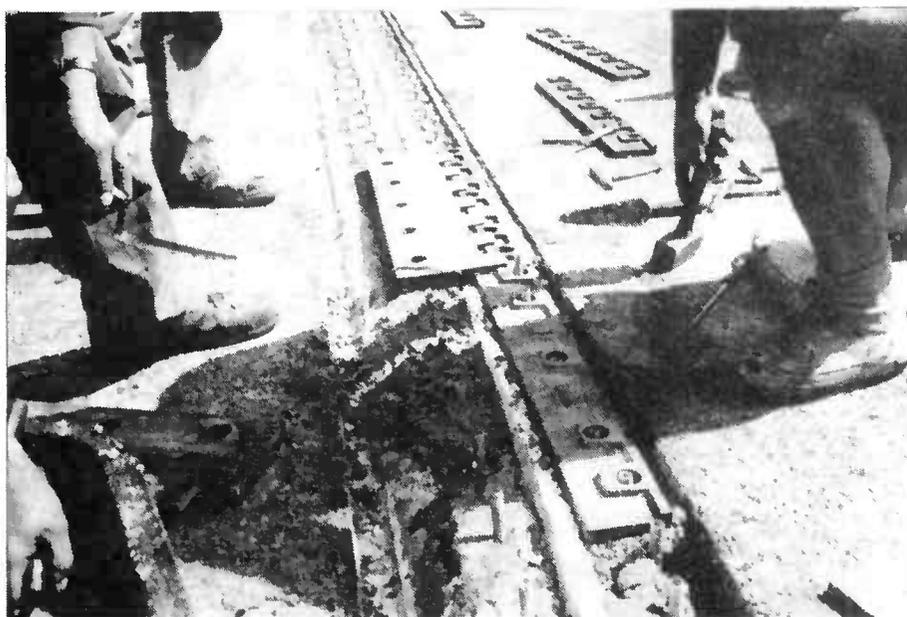
b) Mise en oeuvre du mortier de résine, calage des éléments en se guidant sur les tubes PVC.
