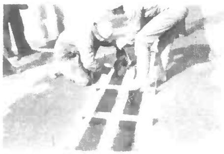
e) Mise en place éventuelle des éléments de fixation du profil d'étanchéité, réglage de l'ouverture, mise en oeuvre du mortier (de résine ou autre).
