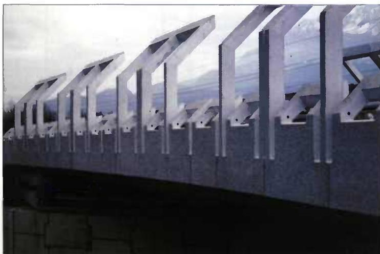
C'est pour ne pas avoir correctement respecté ces règles que toute une série de corniches de ponts franchissant une autoroute a basculé après quelques années de service, quand la corrosion a attaqué les aciers de liaison par ailleurs un peu limités en section.
