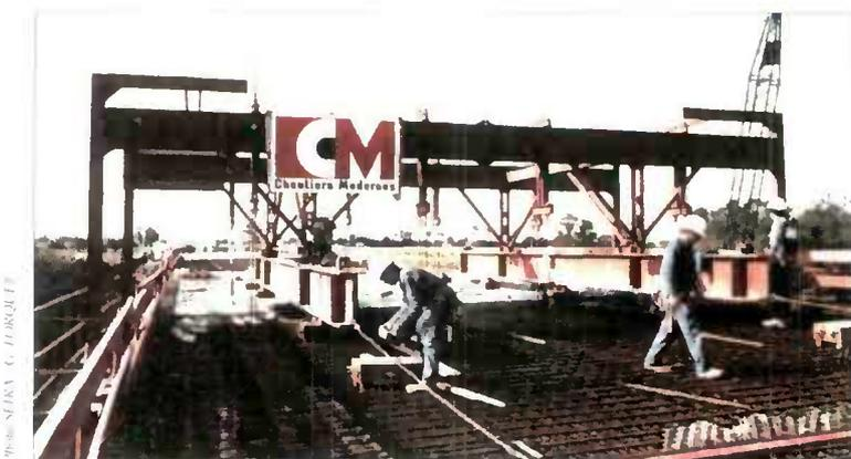
La mise en place du ferrailage minimal permet de contrôler l'ouverture des fissures de retrait.
