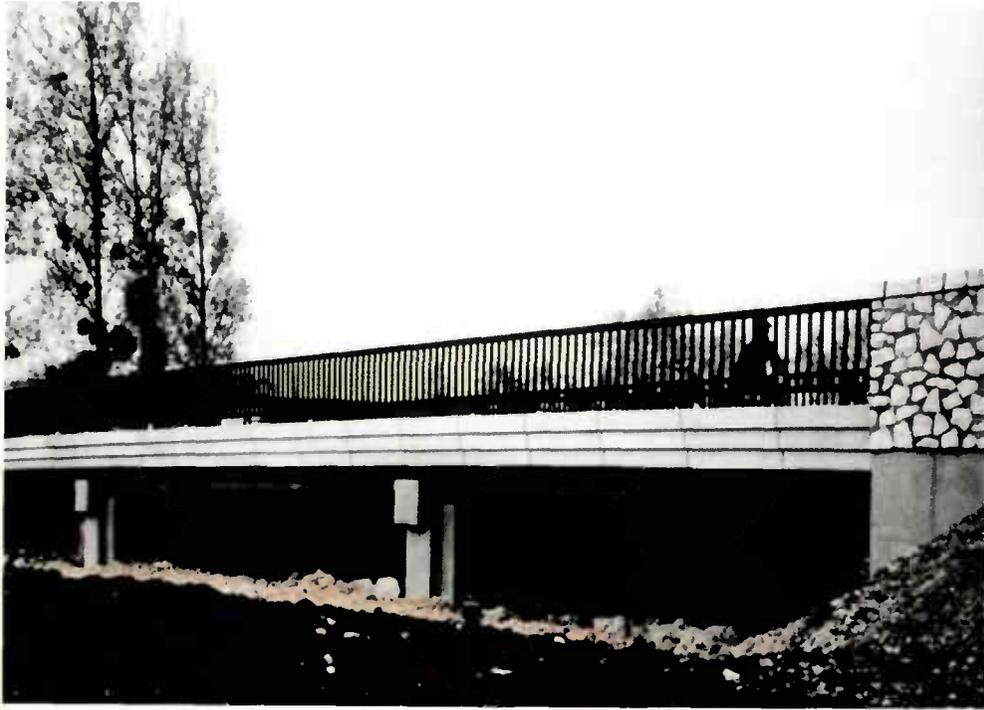
*Figure 64 : Corniches préfabriquées en béton.*
