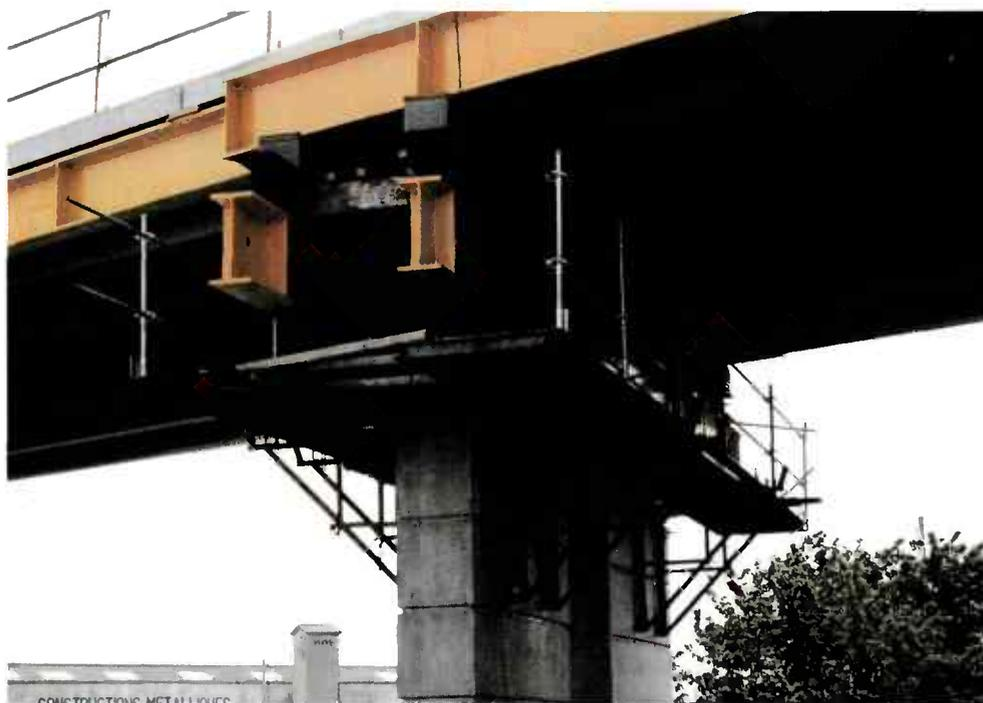
Figure 74 : Coffrages du hourdis en encorbellement.
