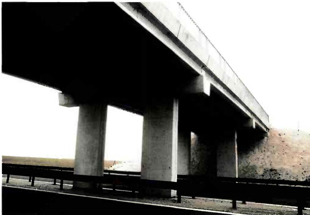
*Figure 8 : Palée à colonnes liées en tête par un chevêtre.*
