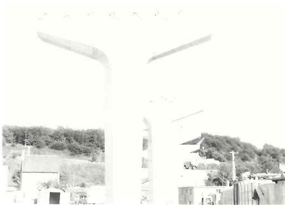
Figure 9 : Pile-marteau.
