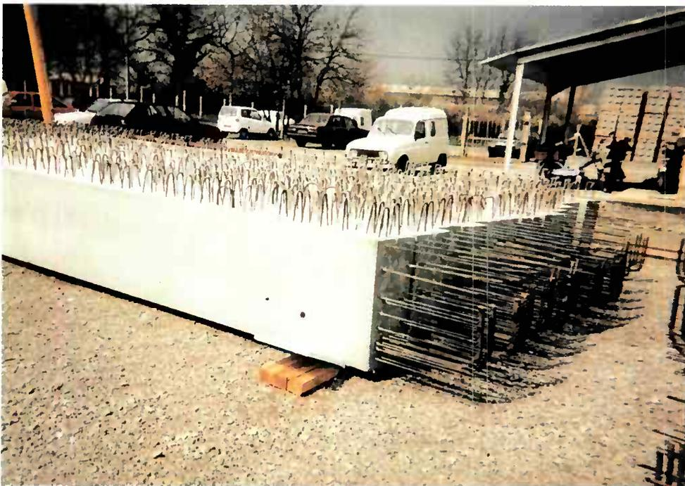
Figure 71 : Stockage des poutres.
