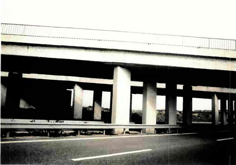
*Figure 27 : Passage inférieur formé par deux demi-ouvrages biais.*
