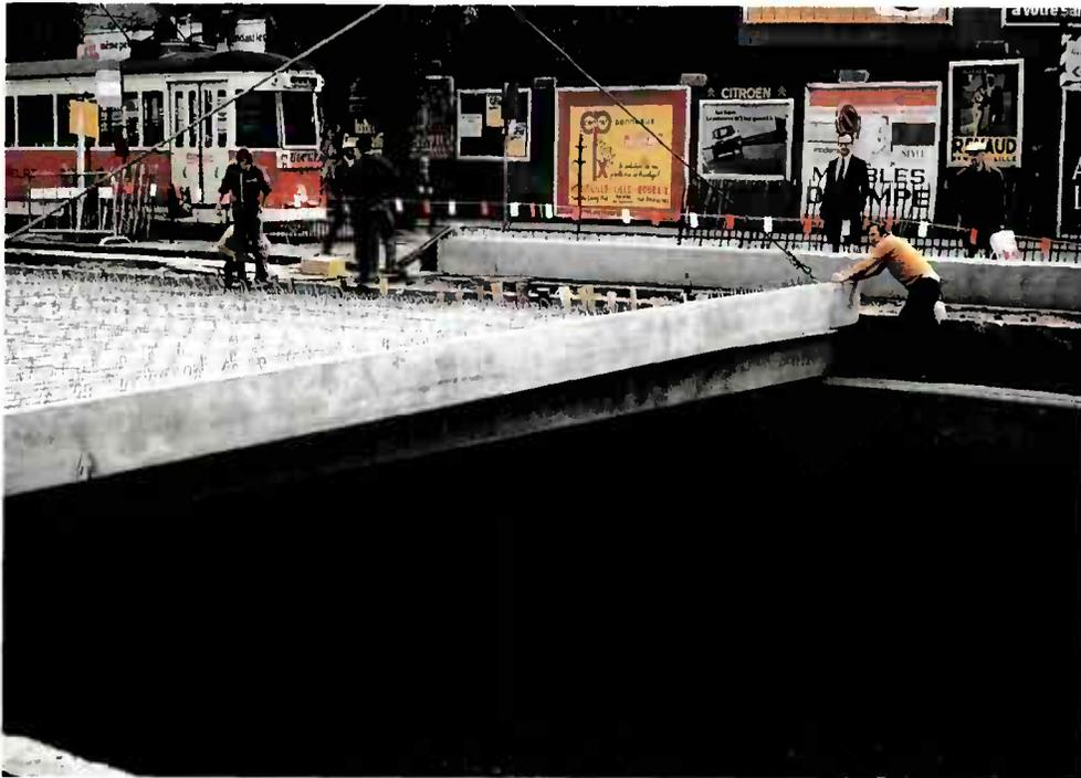
*Figure 10 : Structure de couverture constituée de poutres PRAD.*
