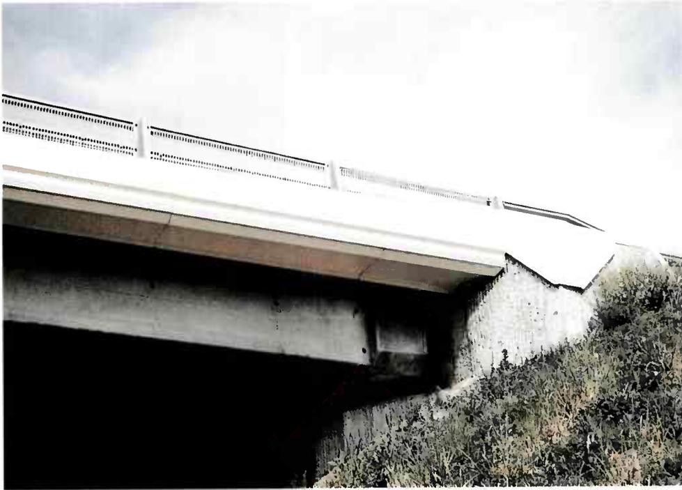
*Figure 67 : Corniches en matériau composite.*
