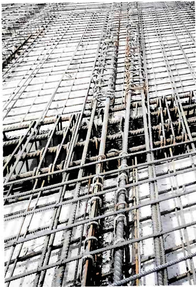
*Figure 53 : Détail du ferrailage de la zone de clavage.*
