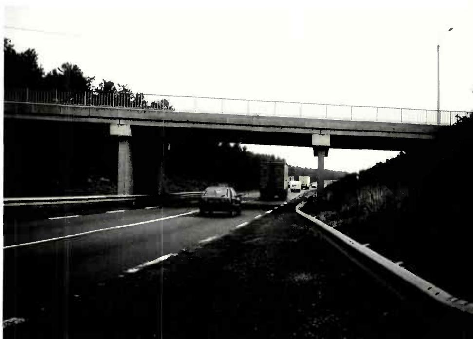
Figure 16 : Aspect d'ouvrage résultant de la continuité par dalle.
