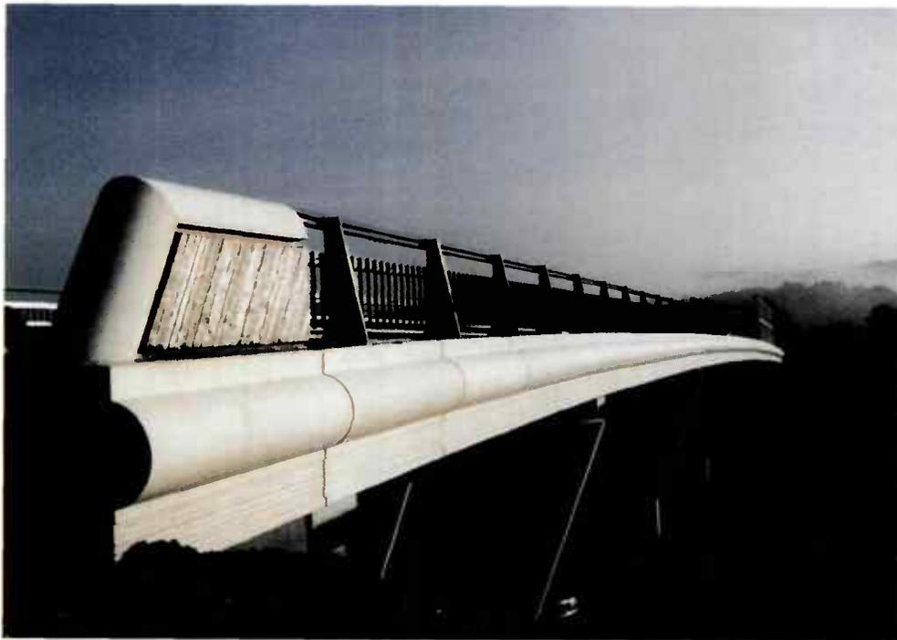
*Figure 65 : Extrémité de tablier avec corniches préfabriquées en béton.*
