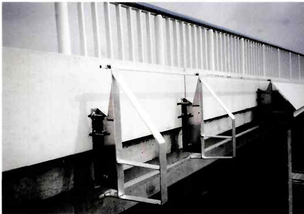
*Figure 62 : Face latérale du tablier avant mise en place des corniches.*
