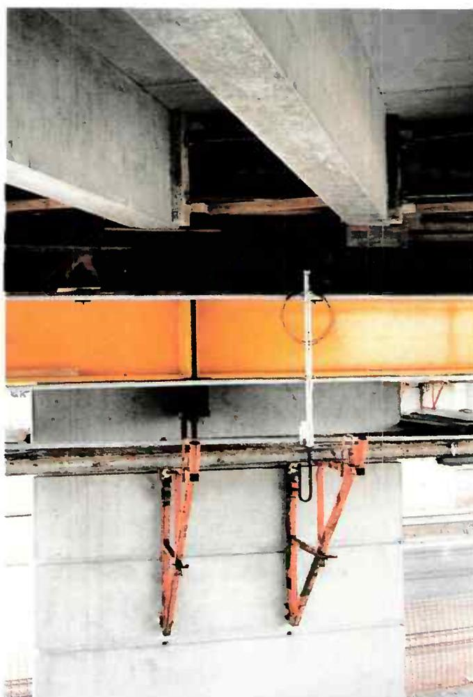
Figure 73 : Dispositif d'appui provisoire.
