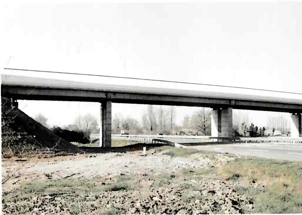
*Figure 68 : Tablier équipé de ses corniches.*
