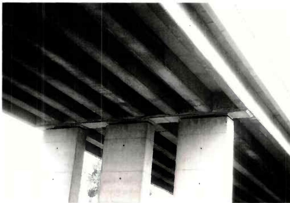
Figure 24 : Aspect d'ouvrage fini sans sommier d'appui.
