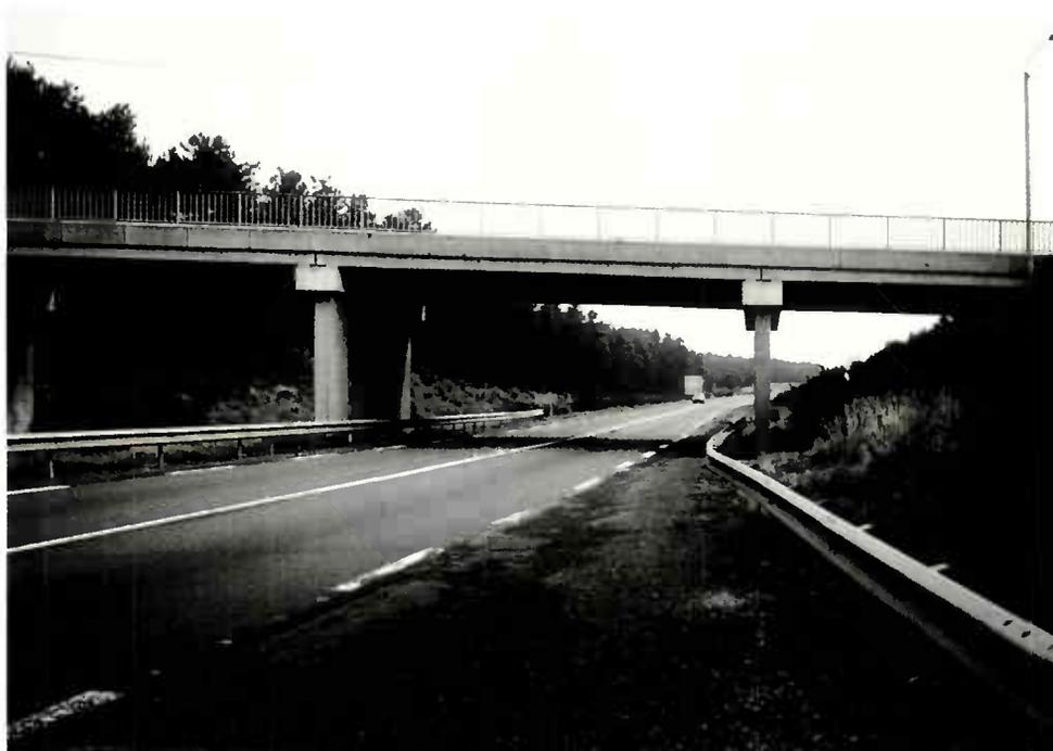
*Figure 39 : Aspect d'ouvrage formé de plusieurs travées indépendantes.*
