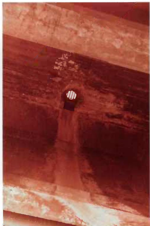
La protection du béton est assurée par la réalisation d'une bonne étanchéité et d'une bonne évacuation des eaux. Elle conduit à soigner l'étanchéité générale, la jonction de l'étanchéité générale avec les joints de chaussée et les avaloirs, l'étanchéité des joints de chaussée ou la récupération des eaux en provenance des joints de chaussée, le drainage, la réalisation de gouttes d'eau et de larmiers, la protection du tablier par la corniche, la position du fil d'eau par rapport au tablier.
