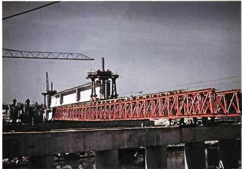
Les lanceurs les plus performants et les plus modernes sont munis d'un système de treuils ou de mouflage, qui permet la manutention et le levage des poutres préfabriquées prises en charge à l'arrière de la travée à franchir. Ces treuils intégrés au lanceur se déplacent sur celui-ci et permettent de positionner la poutre à son emplacement longitudinal définitif.
