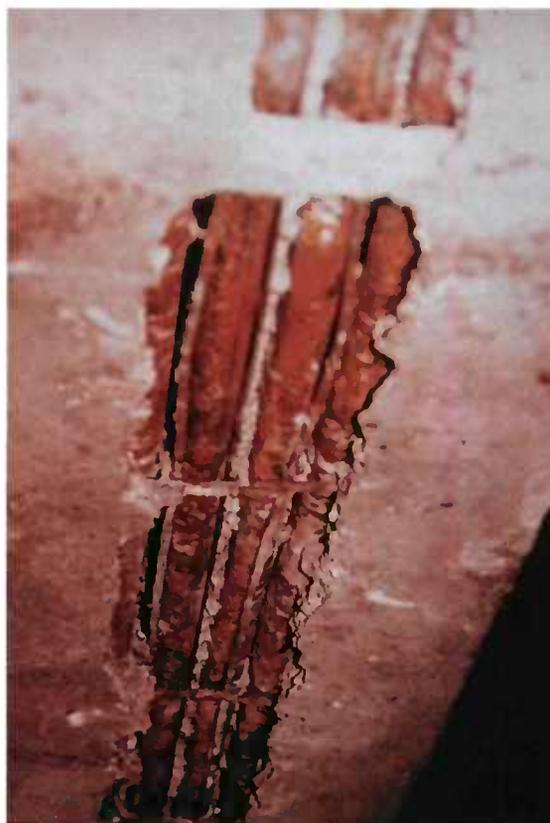
Les conditions de mise en œuvre du béton peuvent également affecter sa résistance. Il peut s'agir d'un traitement thermique mal conduit ou de mauvaises conditions de serrage du béton (insuffisance ou excès de vibration).
