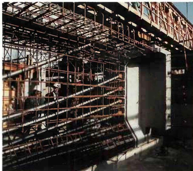
*Ferrailage en place contre l'about préfabriqué*
