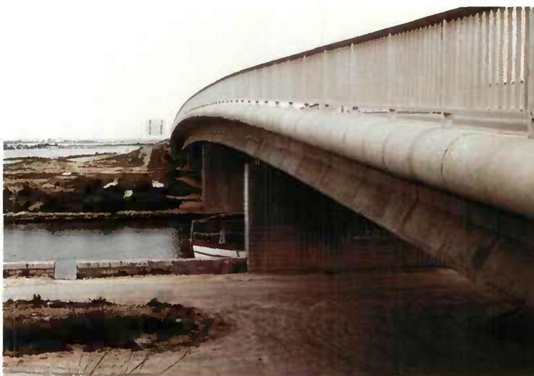
Pour éviter un effet de mur ou de tunnel, il est souhaitable de limiter l'emploi de ces piles aux ouvrages étroits et peu hauts.
