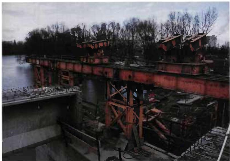
Cependant, la pose directe des poutres de rive n'est bien souvent pas possible, du fait des conditions d'appui du lanceur. Les poutres de rive sont alors posées dans la position la plus excentrée du lanceur et il est nécessaire de procéder en deuxième phase à un ripage ou à une reprise de la poutre sous l'une des poutres du lanceur pour la translater à sa position définitive.
