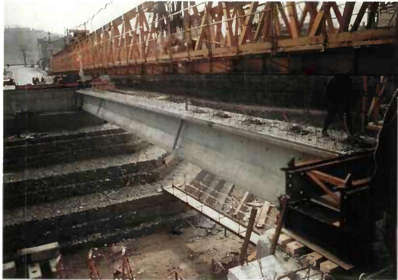
L'intérêt principal du recours à un lanceur provient du fait qu'on ne prend appui que sur les parties de l'ouvrage déjà réalisées, tablier ou piles, ce qui rend la solution totalement indépendante de la brèche à franchir (site accidenté, site aquatique ...).
