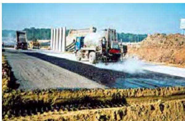
Photo 4 : protection superficielle avec pré gravillonnage — Source : Lhoist
